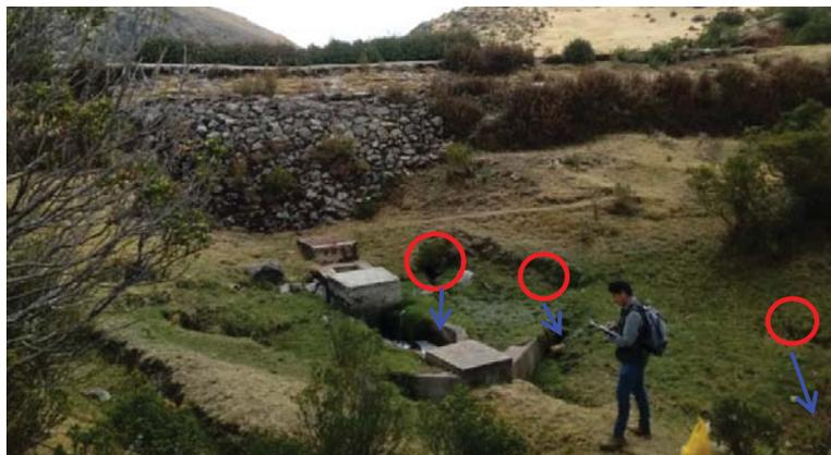
Foto 50. Filtración de agua del pie de talud aguas abajo del dique de represamiento.
