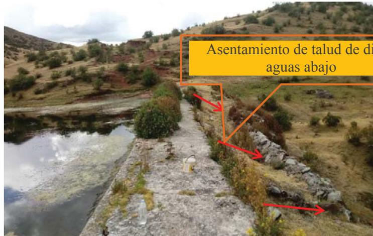
Foto 49. Vista del rip – rap de protección en estado de asentamiento aguas abajo.
