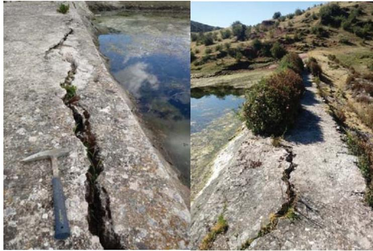
Foto 48. Estado de conservación precaria de la estructura del represamiento laguna Tirina.
