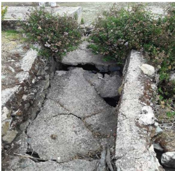
Foto 71. Estado de deterioro de canal de aliviadero de la represa Tirina
