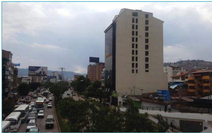
Figura 18: Nuevas construcciones en la Ciudad de Cusco con más de 5 niveles
