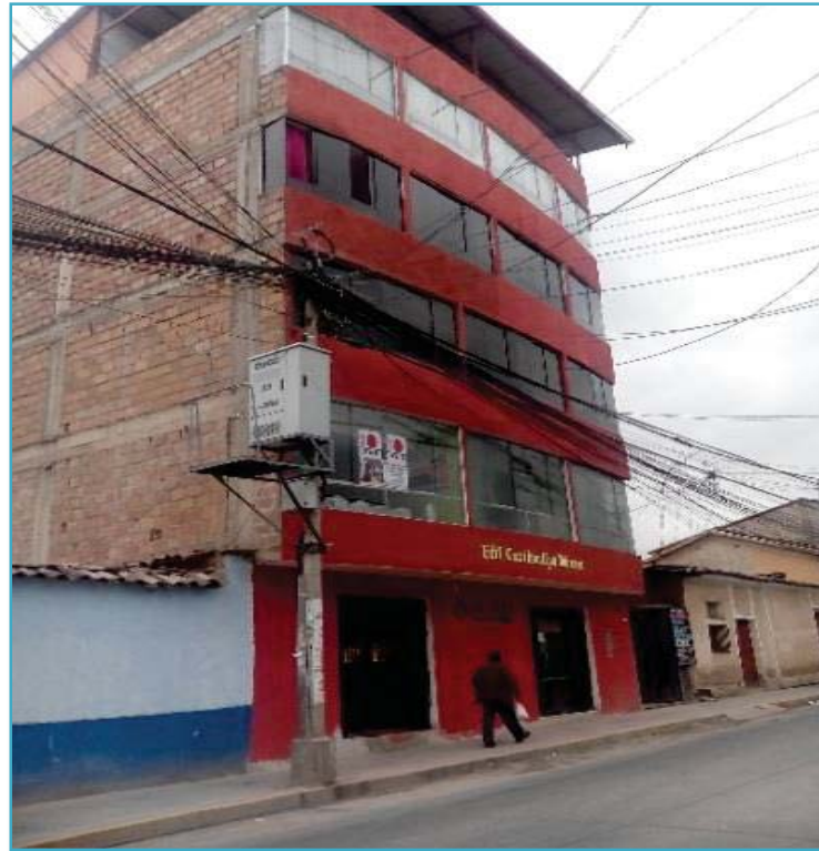
Figura 3: Av. Los Incas Superposición De conductores.
