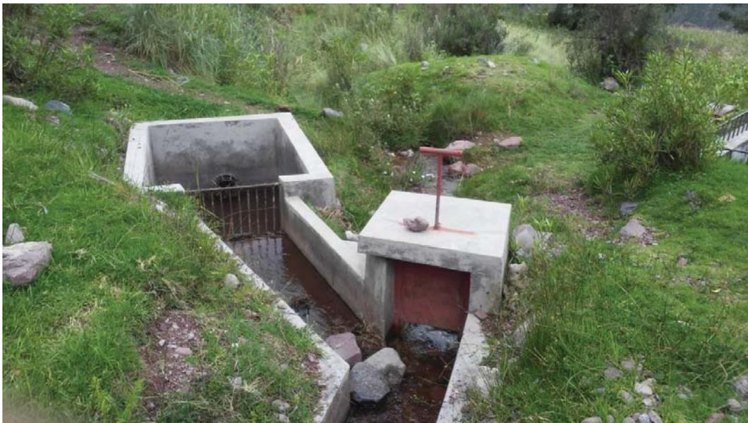
**FOTOGRAFÍA N° 13 COMPUERTA DEL CANAL DE RIEGO PARTE DE ARRIBA.**
