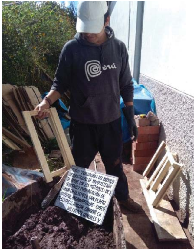
Figura 05.17. Moldes de control de espesor de juntas.
