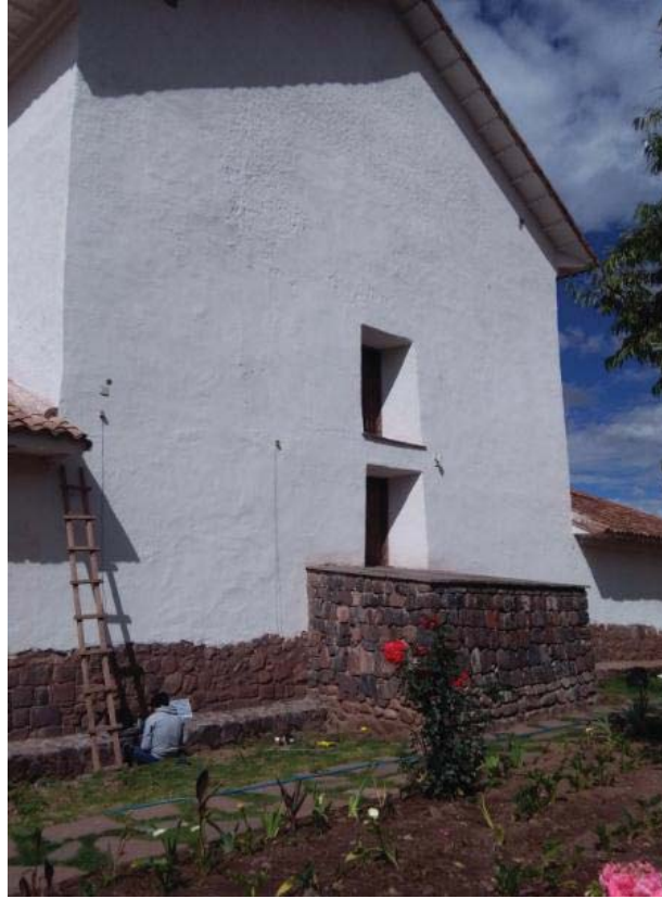
Figura 05.56. Ensayo en dirección horizontal en el sector 07 del templo.
