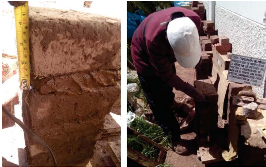
Figura 05.20. Medición del espesor de junta y control de verticalidad con plomada.
