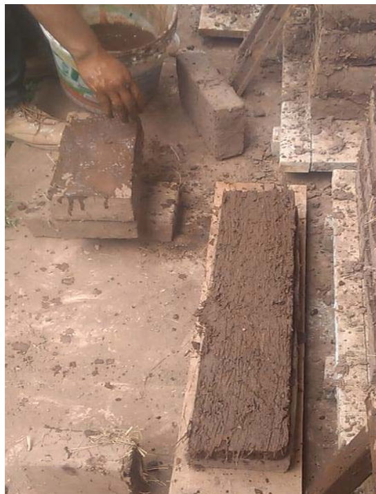
Figura 05.24. Retiro de molde y humedecimiento de unidades.
