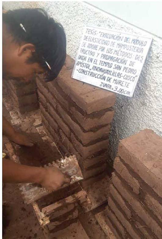
Figura 05.23. Enrasado de mortero de barro.
