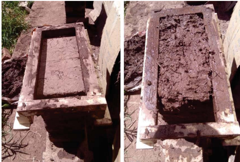
Figura 05.18. Colocación de molde y relleno con mortero de barro al ras.
