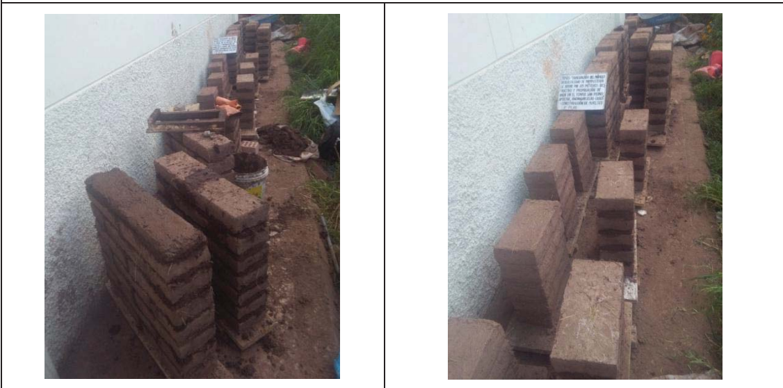
MURETES Y PILAS TERMINADAS
