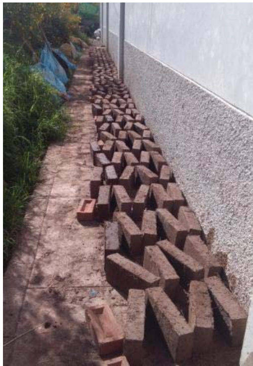
Figura 05.11. Volteado de adobes y perfilado de aristas de la base.
