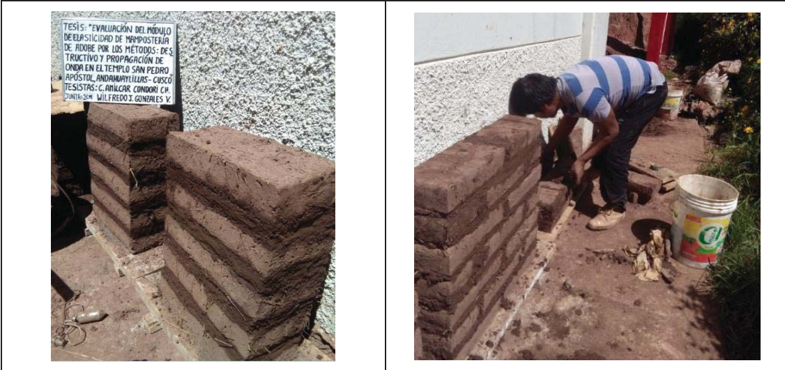
CONSTRUCCIÓN DE PILAS Y MURETES
