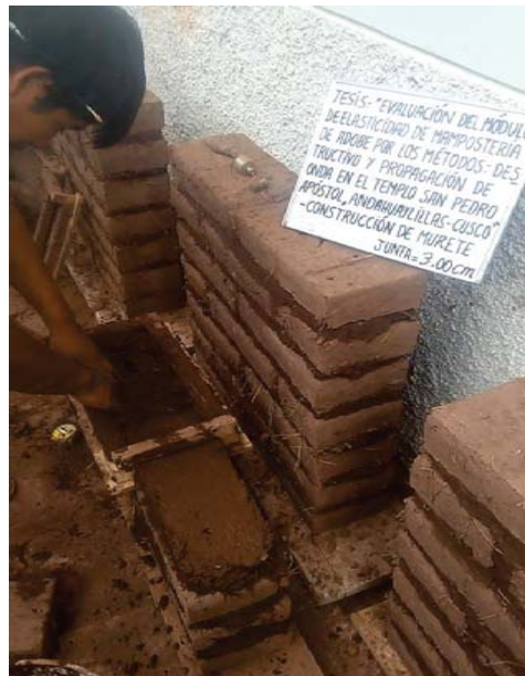
Figura 05.22. Colocación de molde y relleno con mortero de barro.
