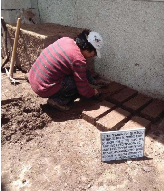
Figura 05.9. Extracción de adobes sobre cama de arena fina.
