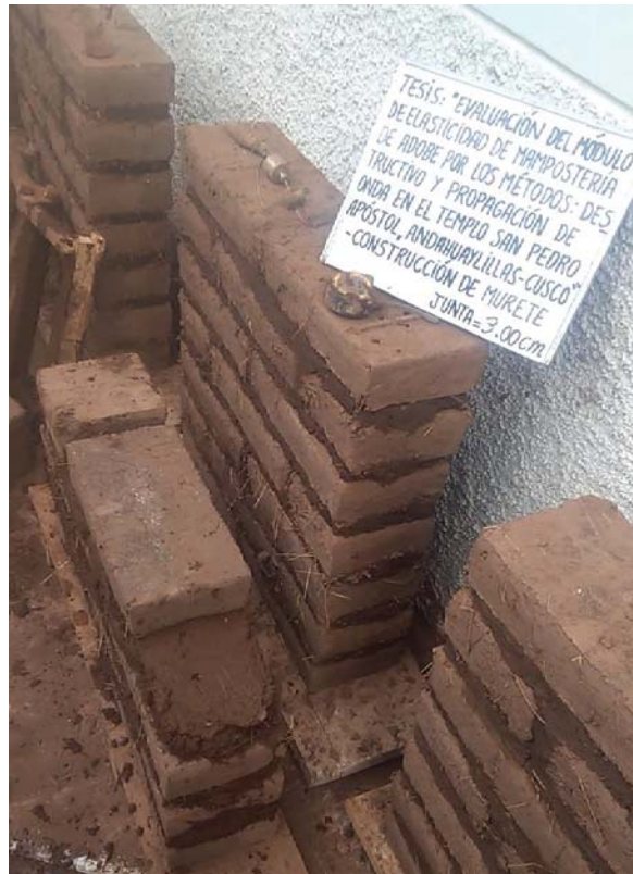
Figura 05.25. Asentado y acomodo de unidades de adobe.
