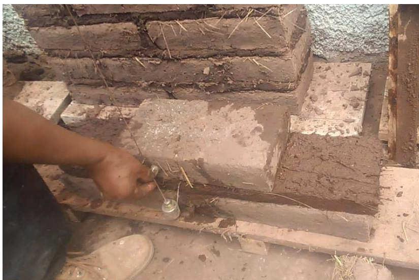
Figura 05.26. Control de verticalidad con plomada.
