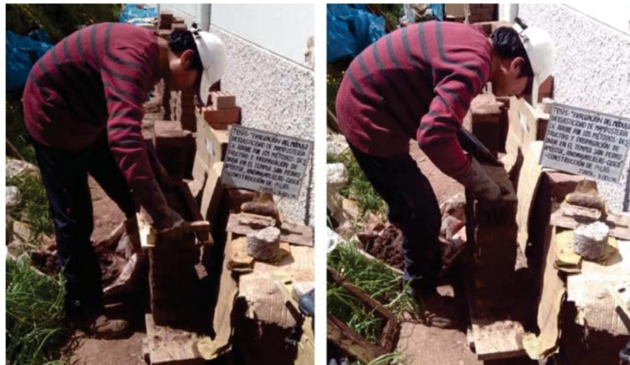
Figura 05.19. Retiro de molde y asentado de adobe.
