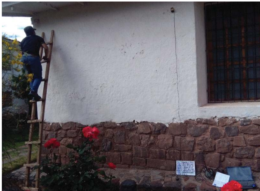
Figura 05.57. Ensayo en dirección horizontal en el sector 08 del templo.
