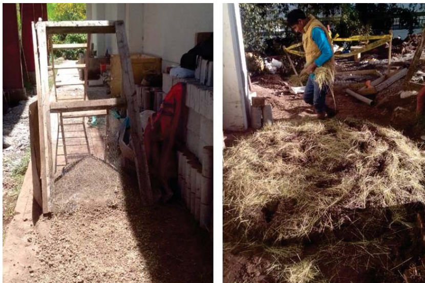
Figura 05.7. Zarandeado de material, mezclado, pisado y adición de paja.
