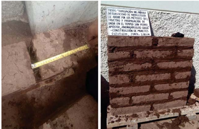
Figura 05.27. Control de espesor de junta y muro terminado e = 2.00 cm.
