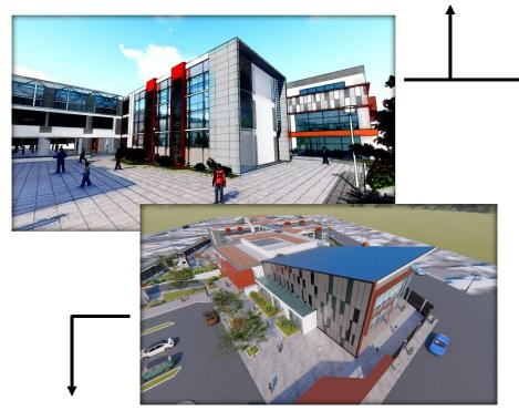
Se plantea el uso, innovador para la zona, del revestimiento con planchas de alucobond en estructuras metálicas.
