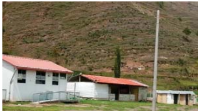
AGEN N° 02, Estado actual de la I.E. 50120 Pucyura. 2017 Archivo propio.
