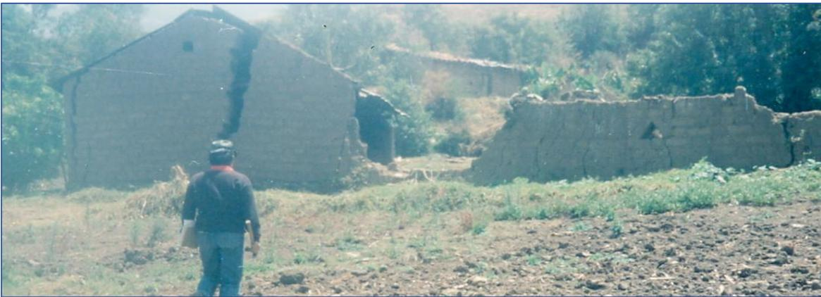
Foto 089: Toma fotográfica del año 1992, mostrando paredes agrietadas en el sector de Puca Puca.
