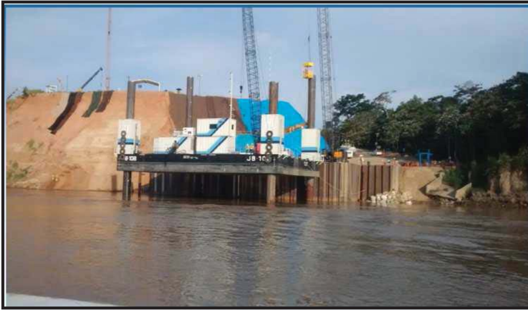
MUELLE, PUNTO DE EMBARQUE DE PILOTES
