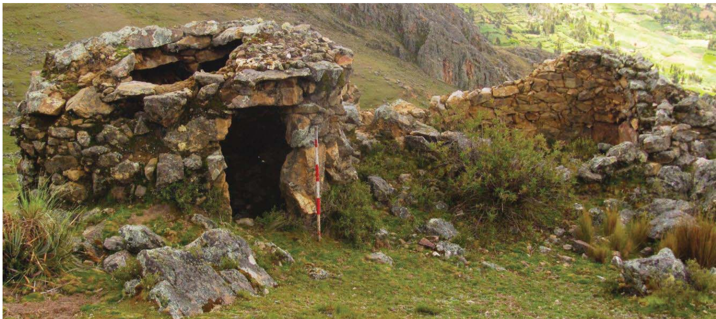
Foto N° 24. Apreciar el tipo de abovedamiento de la cubierta de cierre con una superposición de elementos líticos de tipo laja unidos con mortero de barro y piedras menudas. Fuente Edison Pérez.
