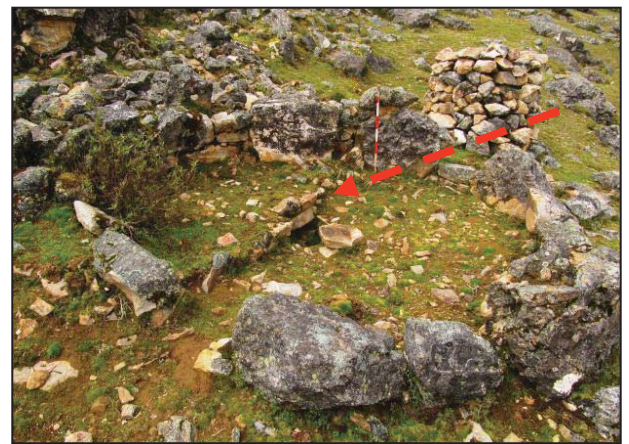
Foto N° 123. S.A. Machupitumarca, recinto con Plataforma interior. Fuente Edison Pérez.
