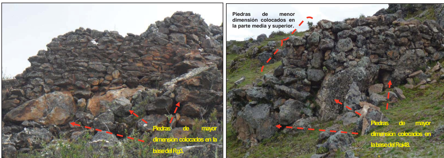
Foto N° 140 y 141: Nótese la colocación de piedras según su tamaño en los recintos. Fuente: E. Gallegos y E. Pérez.
