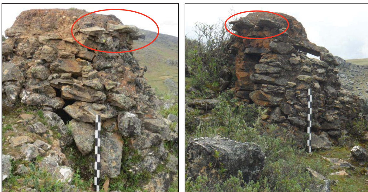
Fotos N° 133 y 134. Disposición de las cornisas alrededor de la cubierta de Rm13 y Rm60. Fuente E. Gallegos y E. Pérez
