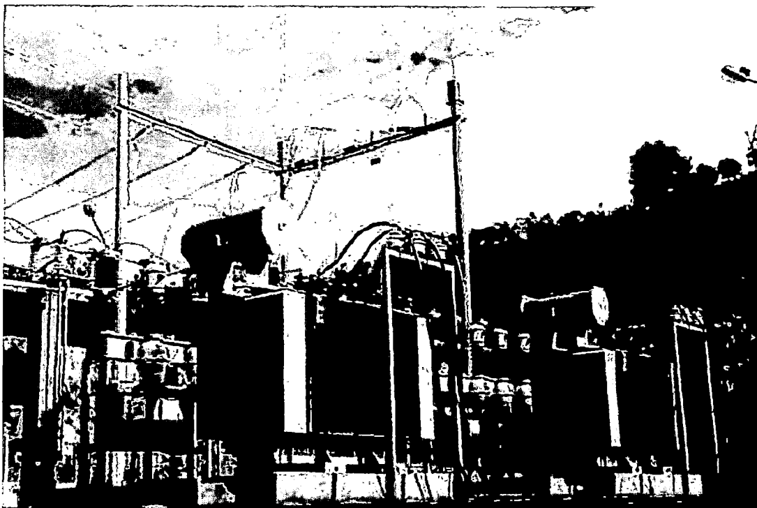
Figura 2. 18 Estación transformadora a la intemperie
