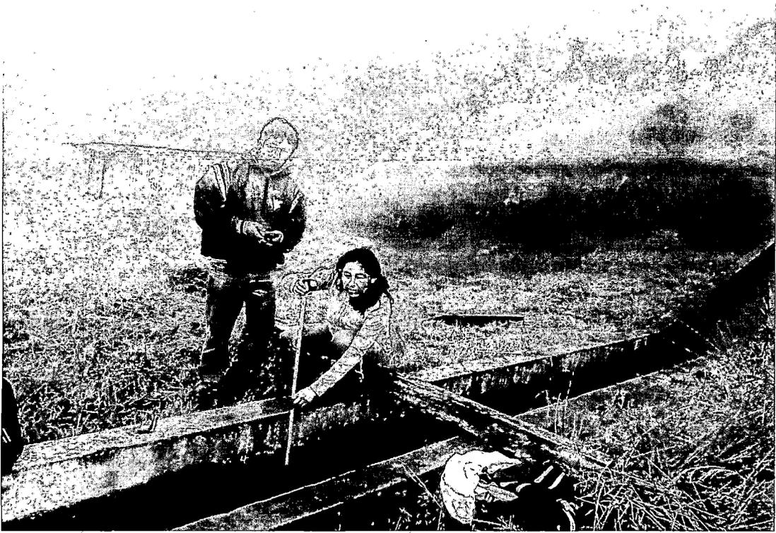
Foto N° 15: Medicion de caudal en el canal princiapal del reservorio Sector: Sambaray Alto
