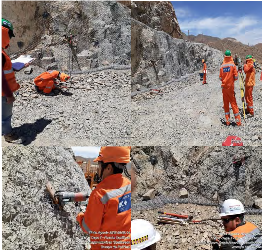
Figura 12 Ensayo de Pull Test
