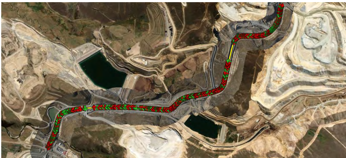
Figura 11: Tramos con peralte por remediar de las vías de acarreo hacia el TMF
