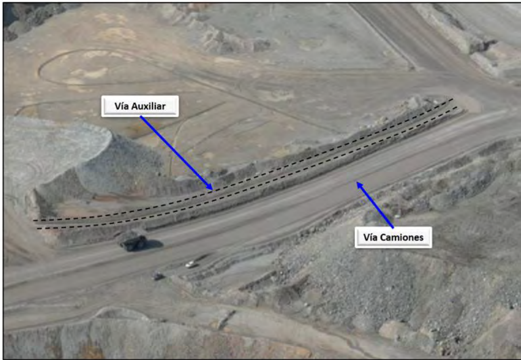
Figura 28: Vía auxiliar de ingreso al stock 40
