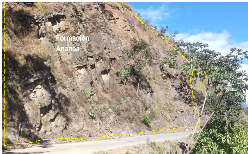
Fotografía 7: Afloramiento de rocas metamórficas pizarras km 05+100, lado derecho.
