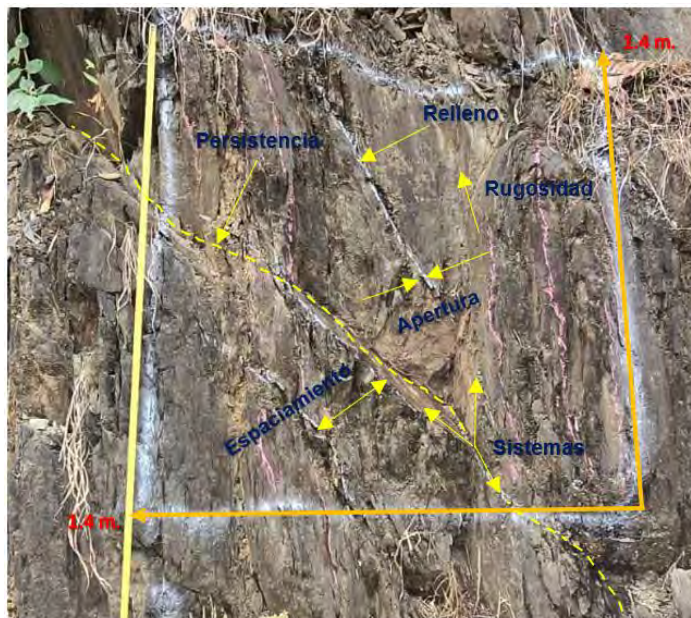
Fotografía 30: Estación Geomecánica 02, EG-02
