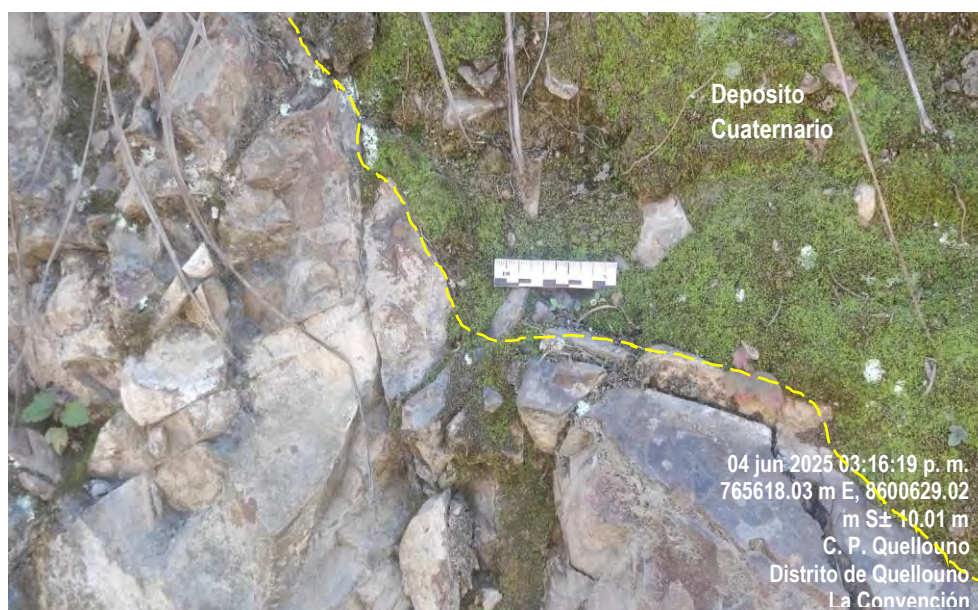
Fotografía 9: Contacto de metareniscas con depósito coluvial en el km 02+850.
