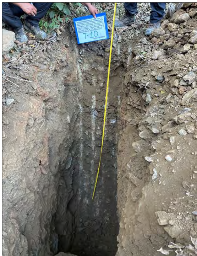
Fotografía 26: Apertura de la Calicata T-10 (Km 09+750).
