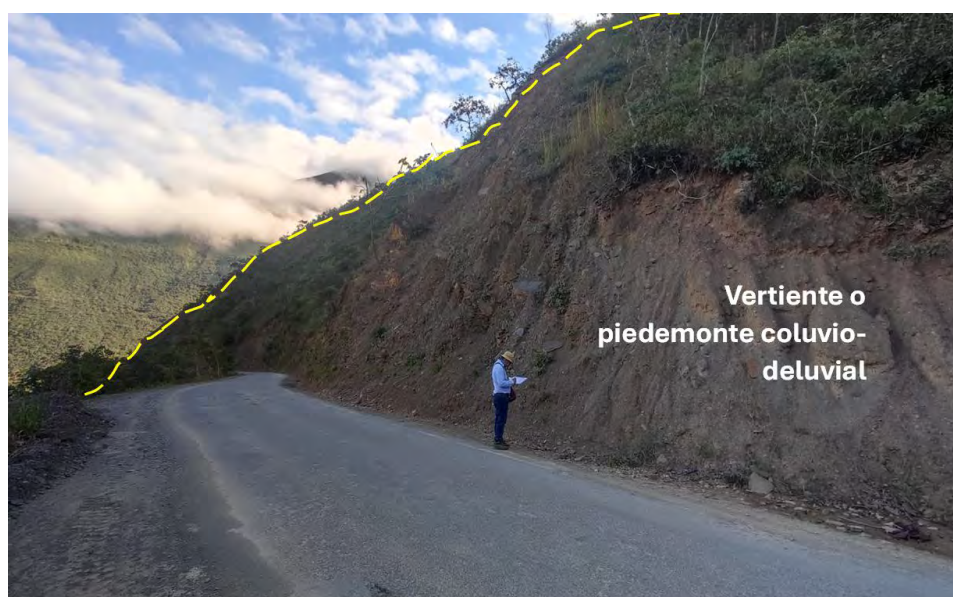
Fotografía 2: Piedemonte coluvio-deluvial caracterizada por depósitos no consolidados y por fragmentos de roca.
