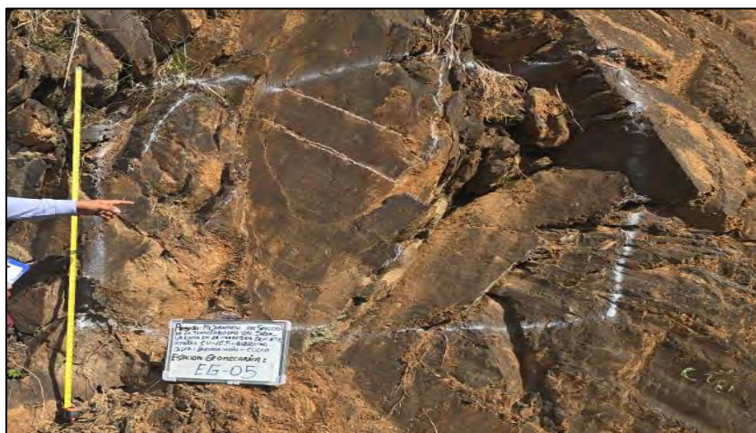
Fotografía 35: Estación Geomecánica 05, EG-05
