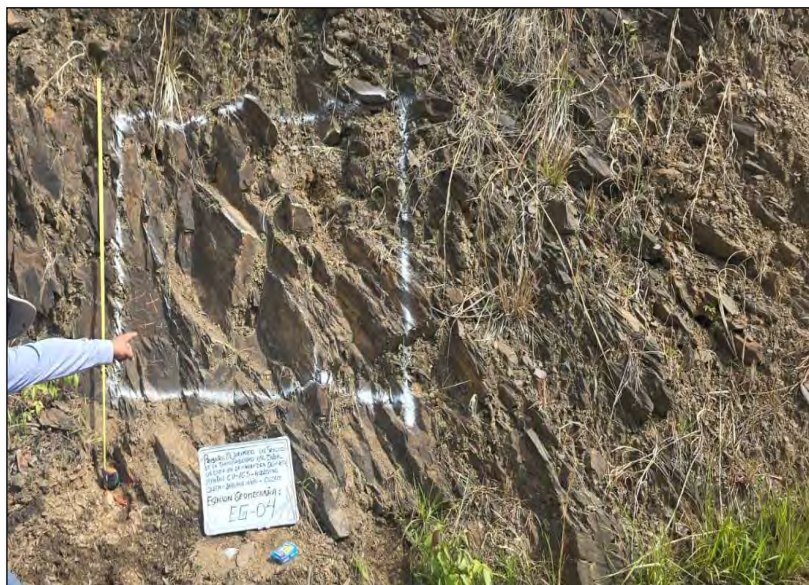
Fotografía 33: Estación Geomecánica 04, EG-04
