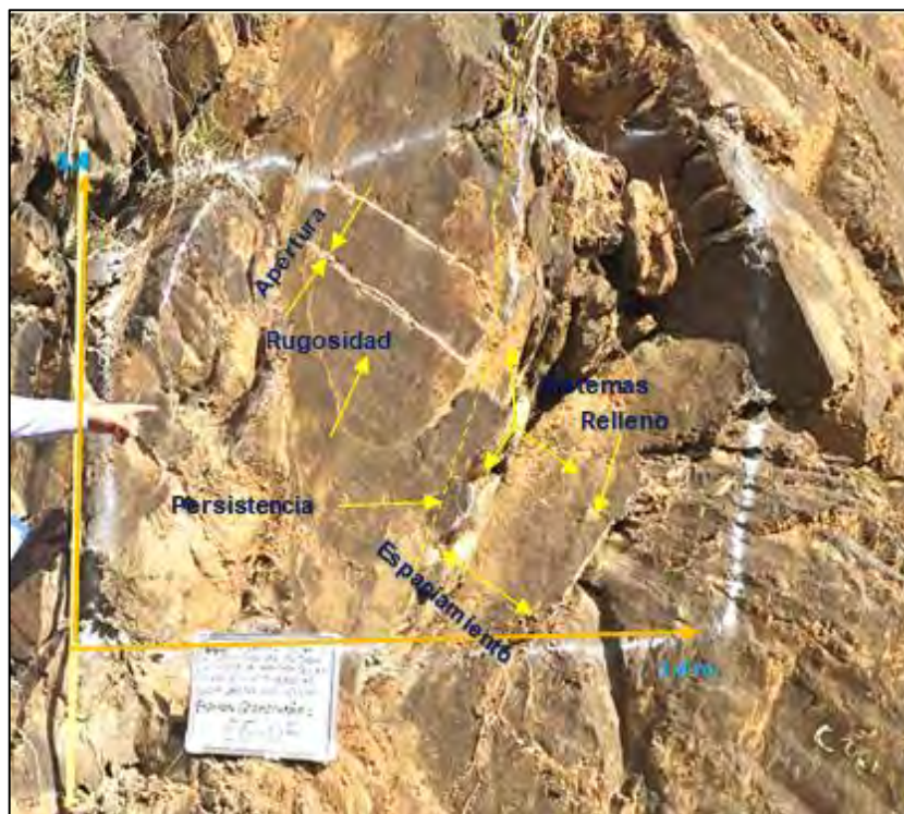
Fotografía 36: Estación Geomecánica 05, EG-05
