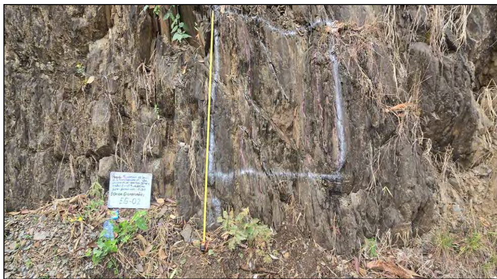
Fotografía 29: Estación Geomecánica 02, EG-02
