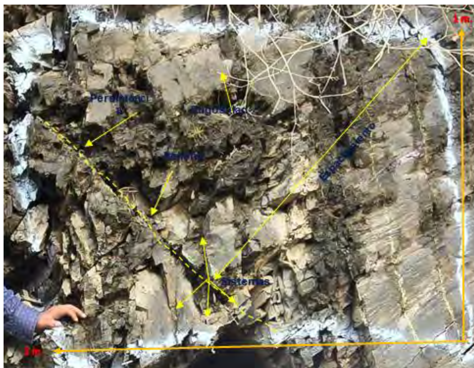
Fotografía 38: Estación Geomecánica 06, EG-06
