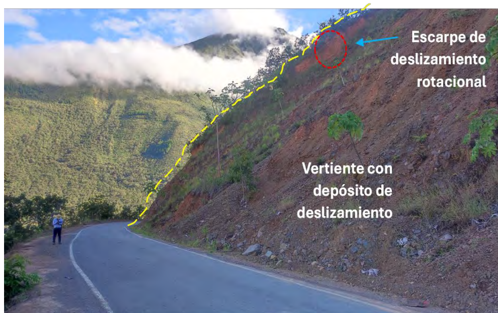
Fotografía 3: Vertiente con depósito de deslizamiento con materiales remanentes de movimientos en masa pasados, con formas lobuladas, escarpes residuales.
