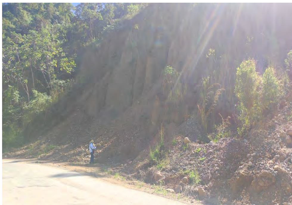
Fotografía 15: Deslizamiento complejo en el km 0+220.
