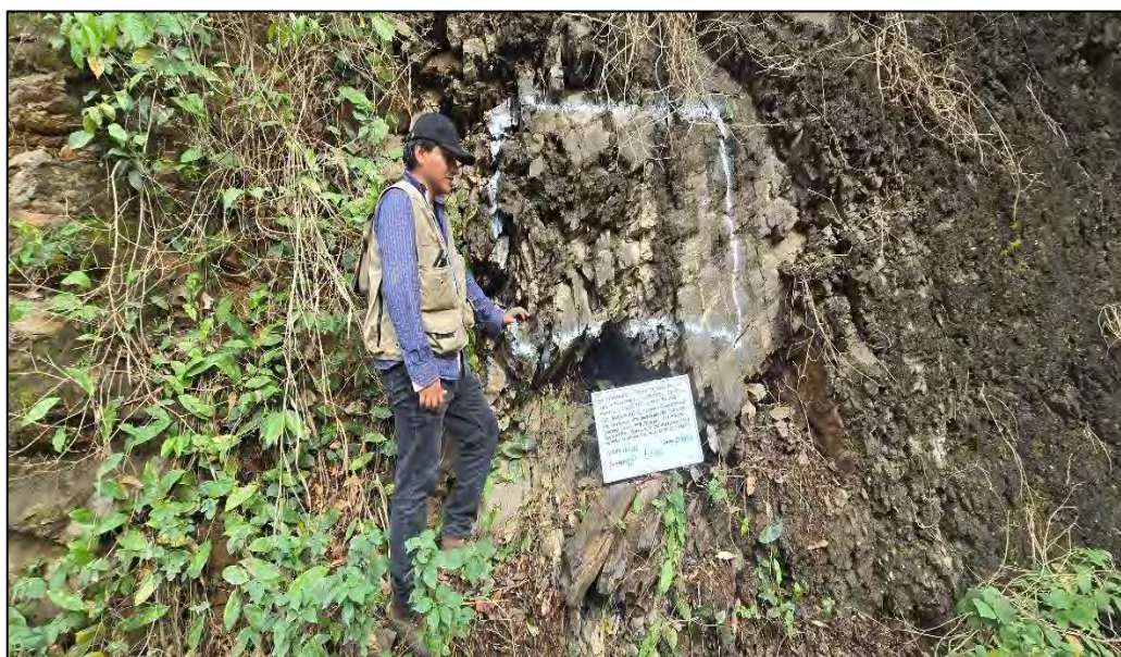
Fotografía 37: Estación Geomecánica 06, EG-06
