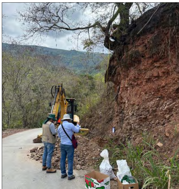
Fotografía 25: Apertura de la Calicata T-03 (Km 02+230).
