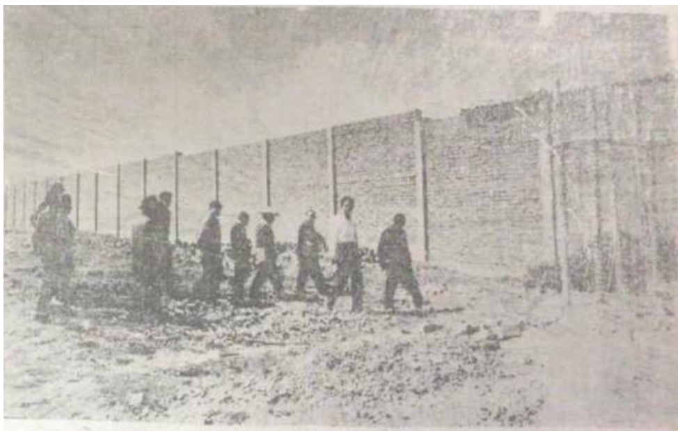
Imagen 9. Inspección de la obra del penal de Q'eqoro por parte de las autoridades (recibiendo explicaciones del Ing. residente).
