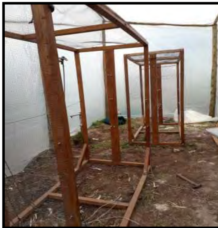
FIGURA 4. Instalación del Módulo de producción de FVH
