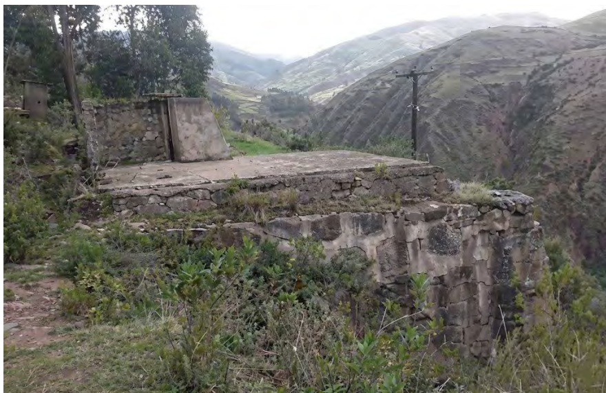
Cámara de carga en la actualidad
