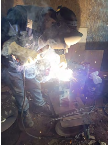
Figura 132. Proceso de Soldadura del Soporte de rueda.
