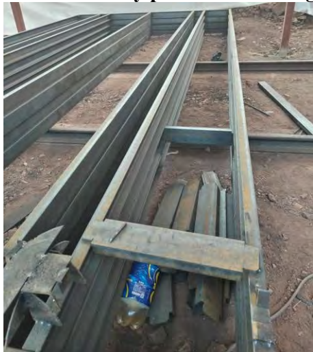
Figura 139. Armado y puenteo de las vigas principales y transversales de 4 cuerpos.
