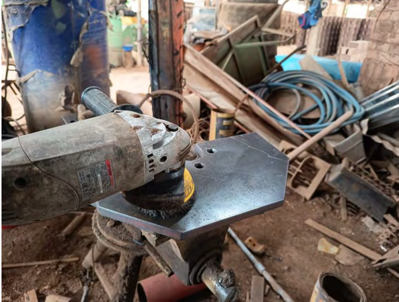
Figura 127. Limpieza con Amoladora y cepillo de alambre trenzado de 3".
