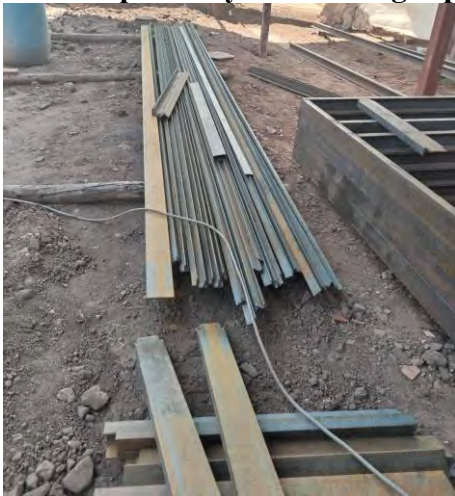
Figura 138. Preparado y corte de vigas principales
