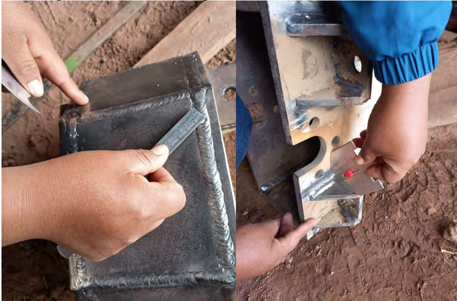
Figura 147. Inspección con Medidor para filete de Soldadura.
