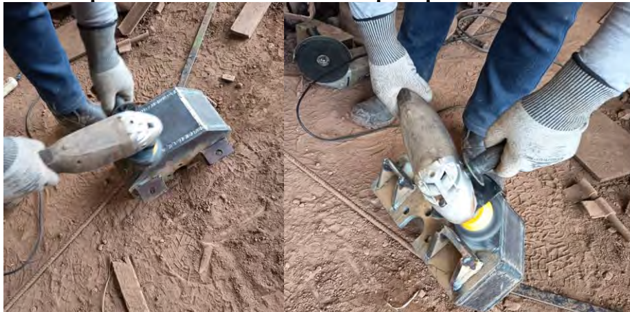
Figura 150. Limpieza mecánica con escobilla tipo copa con amoladora.
