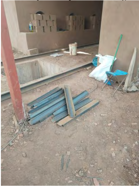
Figura 137. Preparado y corte de Vigas transversales.
