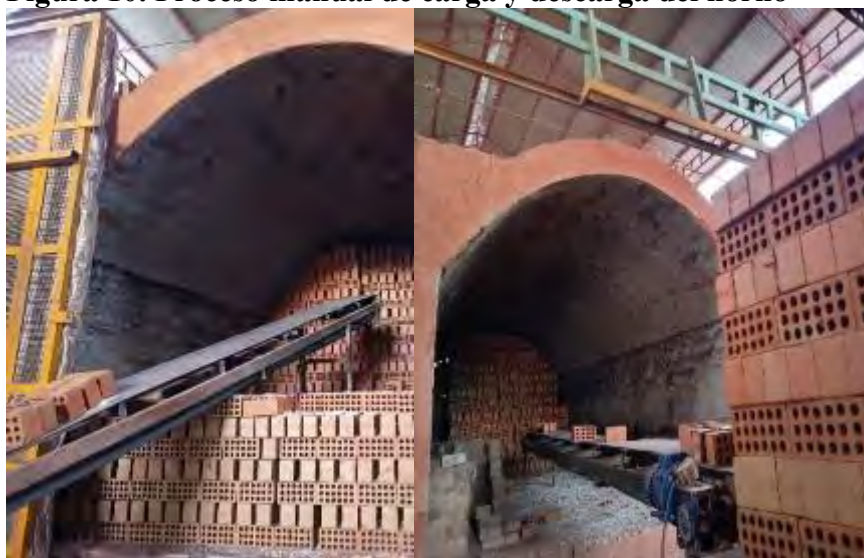
Figura 10. Proceso manual de carga y descarga del horno
