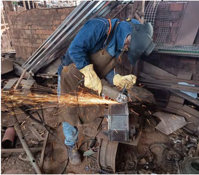
Figura 131. Proceso de Limpieza y biselado para la Soldadura de Soporte de Rueda.
