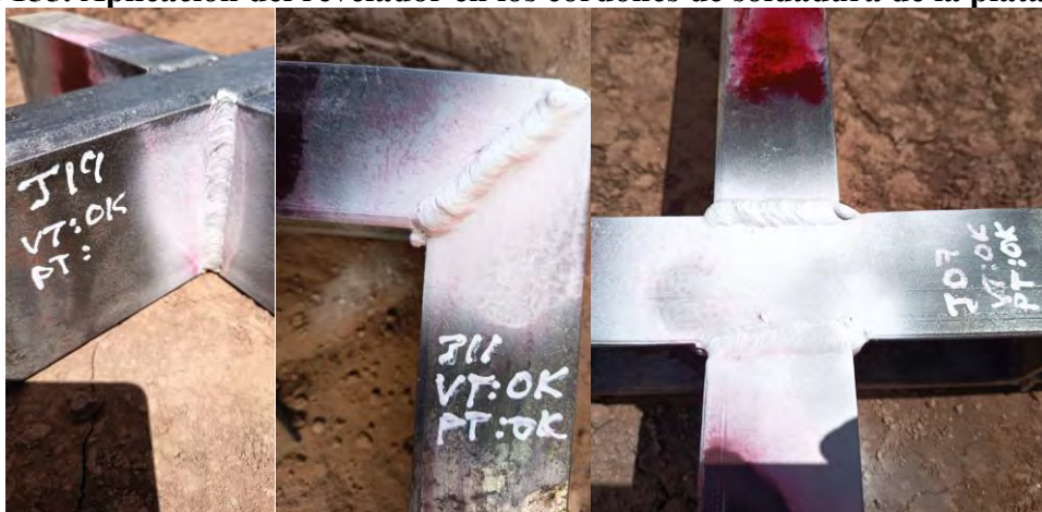
Figura 155. Aplicación del revelador en los cordones de soldadura de la plataforma.
