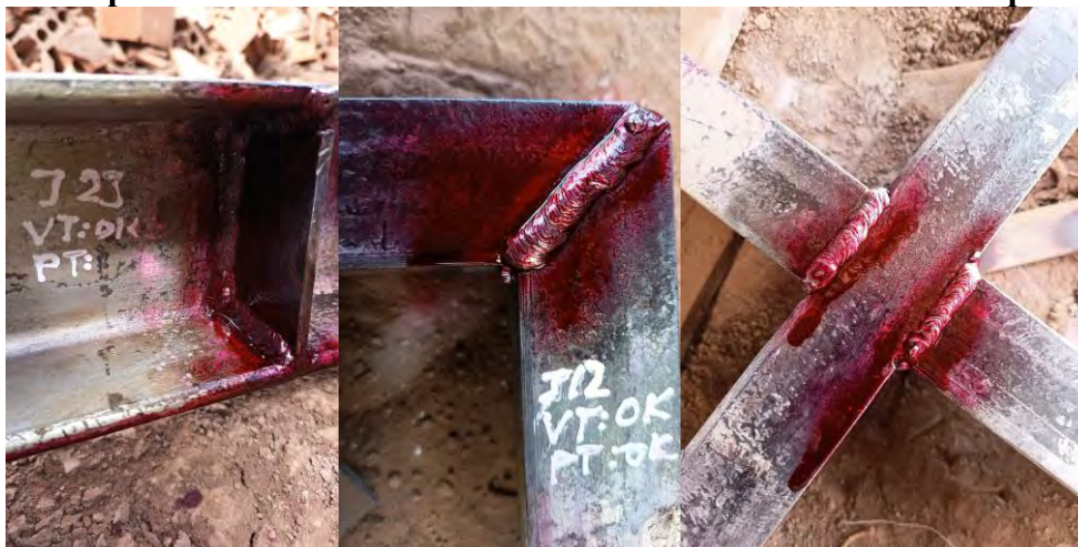
Figura 154. Aplicación del Penetrante en los cordones de soldadura de la plataforma.
