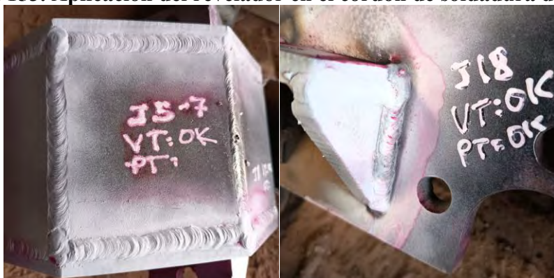
Figura 153. Aplicación del revelador en el cordón de soldadura del soporte de Rueda.
