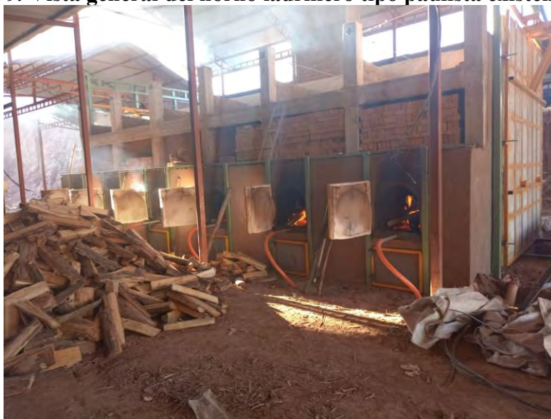
Figura 9. Vista general del horno ladrillero tipo paulista existente
