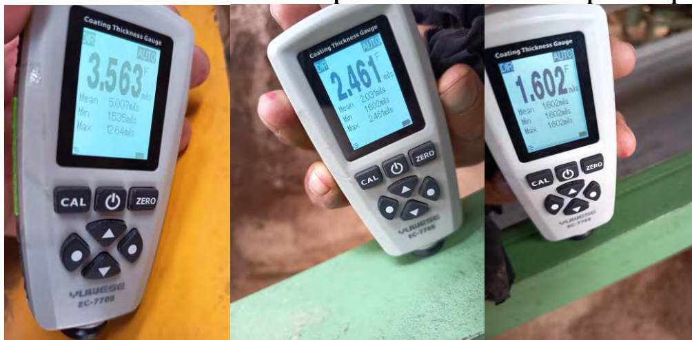
Figura 156. Medición de recubrimiento superficial con medidor de espesor de pintura.
