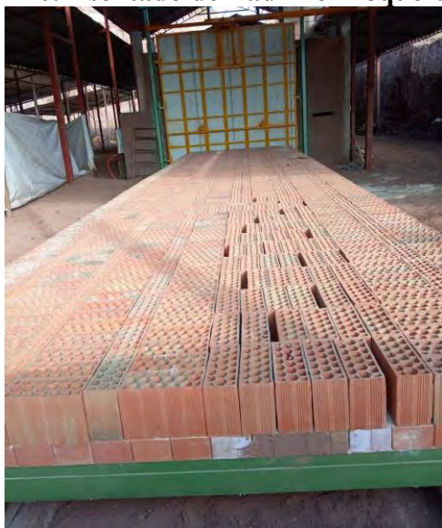
Figura 140. Asentado de Ladrillo Bloquer.
