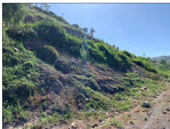
Figura 89: Estabilización de talud con vegetación
