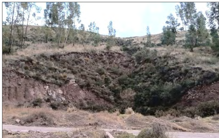
Figura 11: Cárcava natural rellena para la habilitación de carretera.
