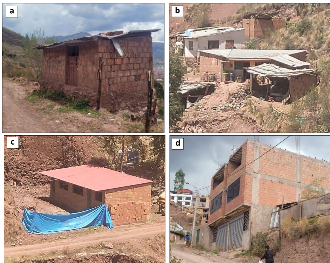
Figura 83: (a) Vivienda deshabitada de ladrillo con barro sin columnas en la APV Lucero de la Mañana, (b) vivienda habitada de palos y calamina en la APV Lucero de la Mañana, (c) vivienda de ladrillo en la APV Villa Quebrada, (d) vivienda de concreto armado en la APV Los Girasoles.
