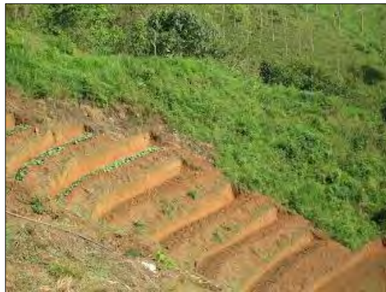
Figura 88: Estabilización de talud con banquetas
