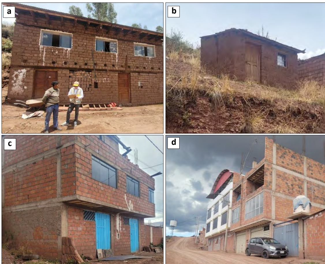
Figura 84: (a) Vivienda de adobe de 2 niveles en la APV Lucero de la Mañana, (b) vivienda de adobe de 1 nivel en la APV Villa Residencial San Antonio, (c) vivienda de concreto armado de 3 niveles en la APV Los Girasoles, (d) vivienda de concreto armado de 4 niveles en la APV Los Girasoles.
