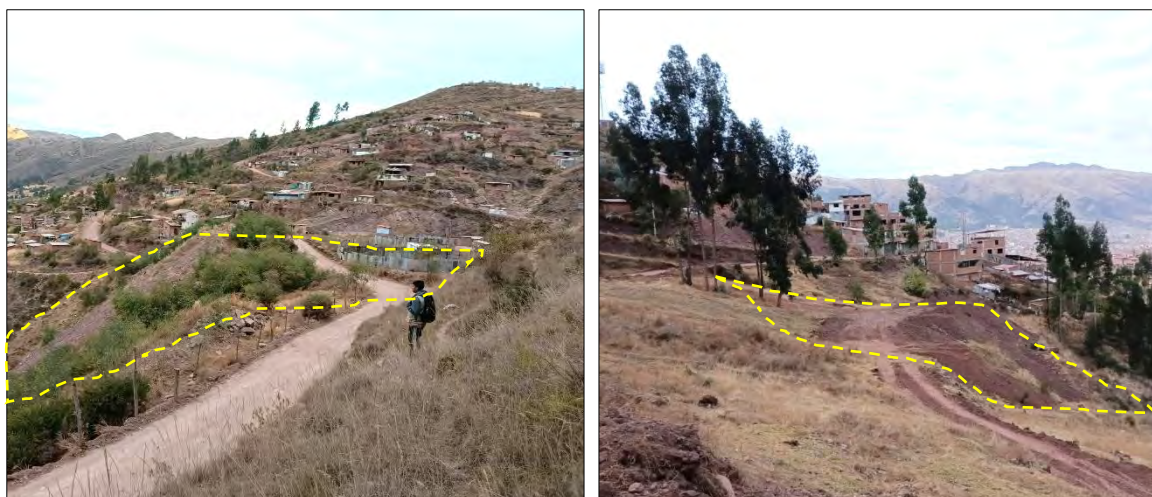
Figura 12: Plataforma de relleno con fines de lotización y ampliación de la carretera.
