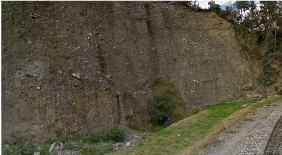
Fotografía 16: Arena limosa bien gradada con presencia de gravas subangulosas
