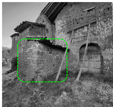
Fotografía 28: Contrafuerte añadido en el muro de pies
