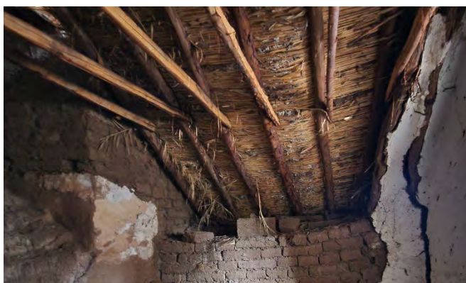
Fotografía 31: Conexiones y apoyo del techo par y nudillo del templo Santa Lucia
