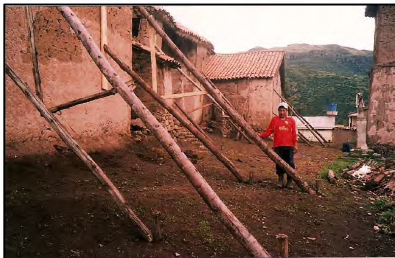
Fotografía 9: Apuntalamiento en muros
