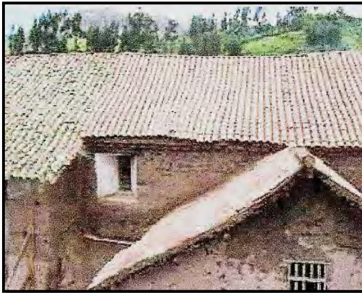
Fotografía 4: Restitución de tejas en coberturas
