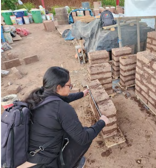
Fotografía 17 Construcción de muretes de adobe para obtención de resistencia a corte.
