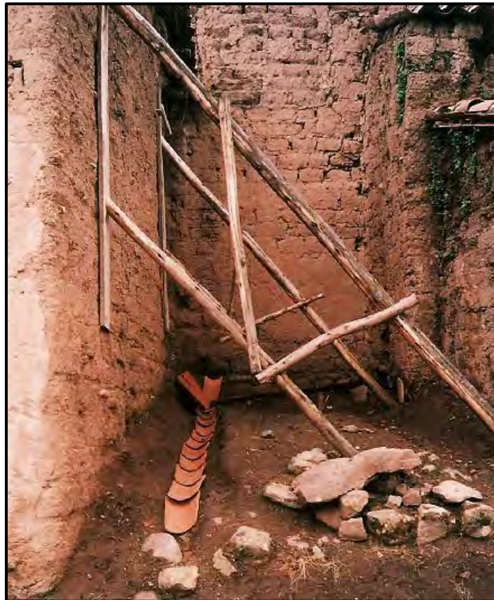
Fotografía 10: Apuntalamiento de contrafuertes y zanja de drenes
