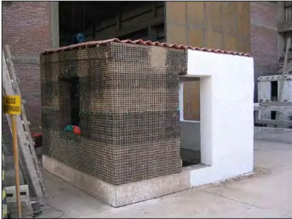
Figura 54: Muro de adobe reforzado con geomalla
