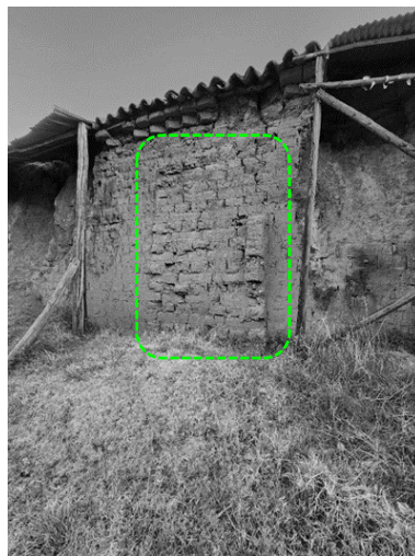
Fotografía 13: Restos del contrafuerte de la epístola
