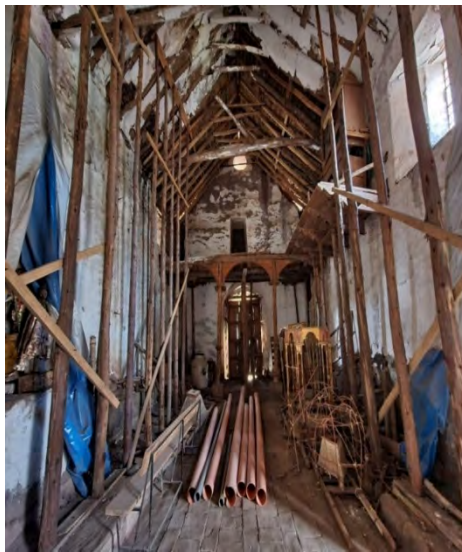
Figura 5: Sistema del techo del Templo de Santa Lucia (vista interior)
