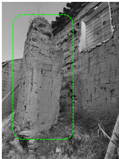
Fotografía 12: Contrafuerte de la epístola.
