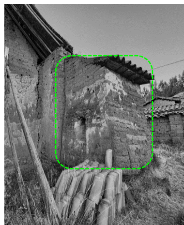
Fotografía 23: Contrafuerte añadido en el muro de pies (a).
