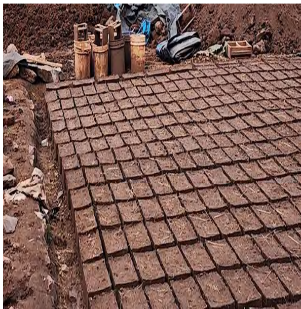
Fotografía 15 Reconstrucción de adobes para el ensayo de pilas y muretes.
