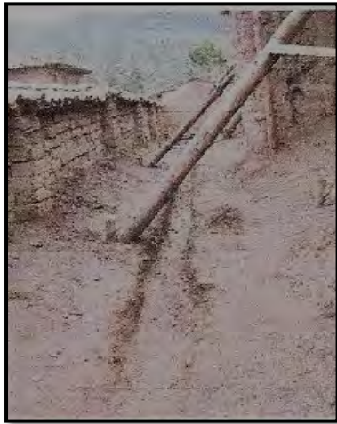
Fotografía 6: Zanjas de drenes y limpieza de maleza
