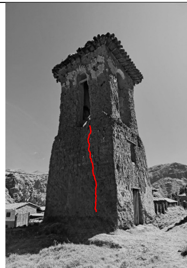
Fotografía 26: Grieta longitudinal
