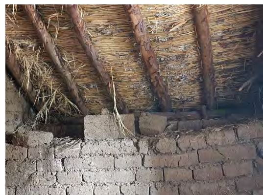
Fotografía 31: Conexiones y apoyo del techo par y nudillo del templo Santa Lucia
