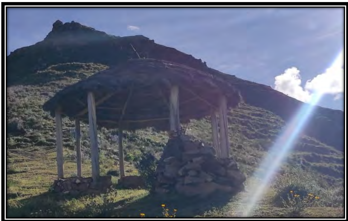
Caseta de mirador
