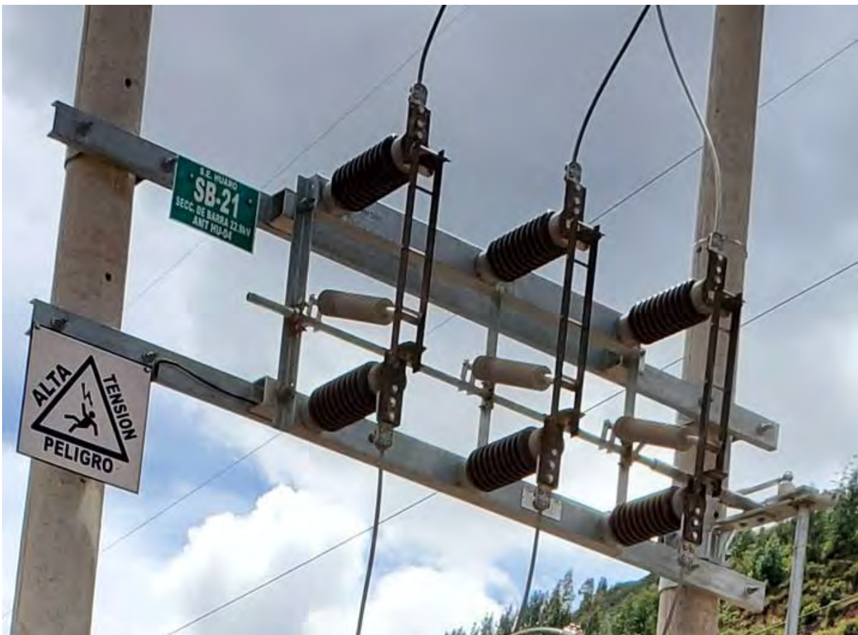
Figura 3.16. Seccionador de barrada de 22.9 kV AMT HU-04.
