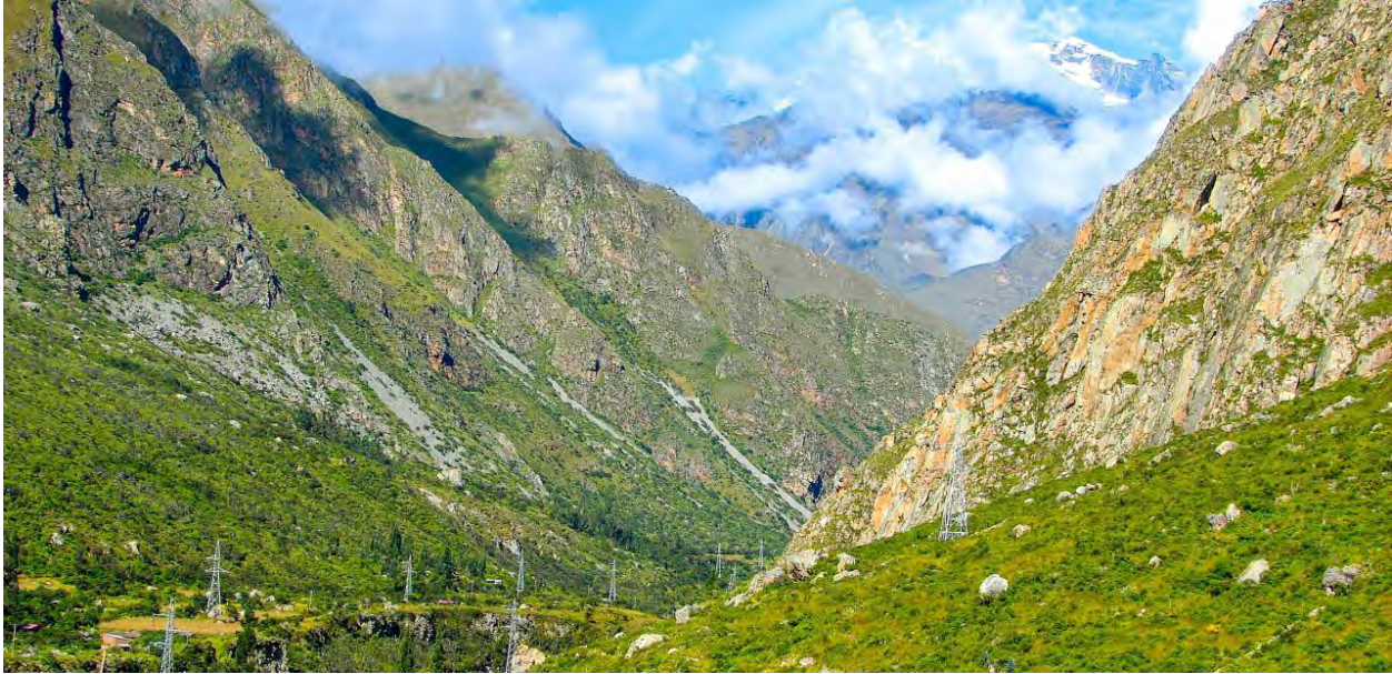
Figura 2.3. Líneas de transmisión en operación en Machupicchu.
