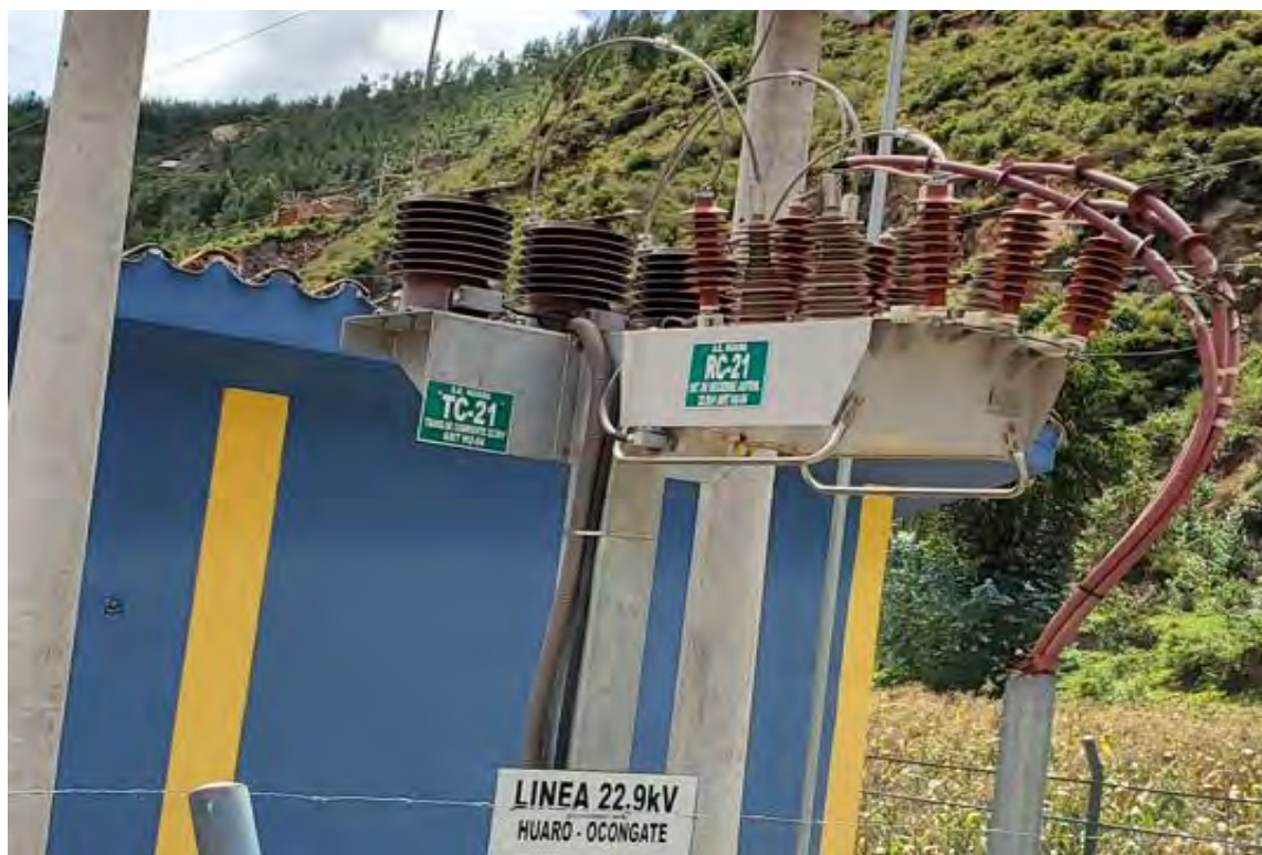
Figura 3.14. Reconectador automático RC-21
