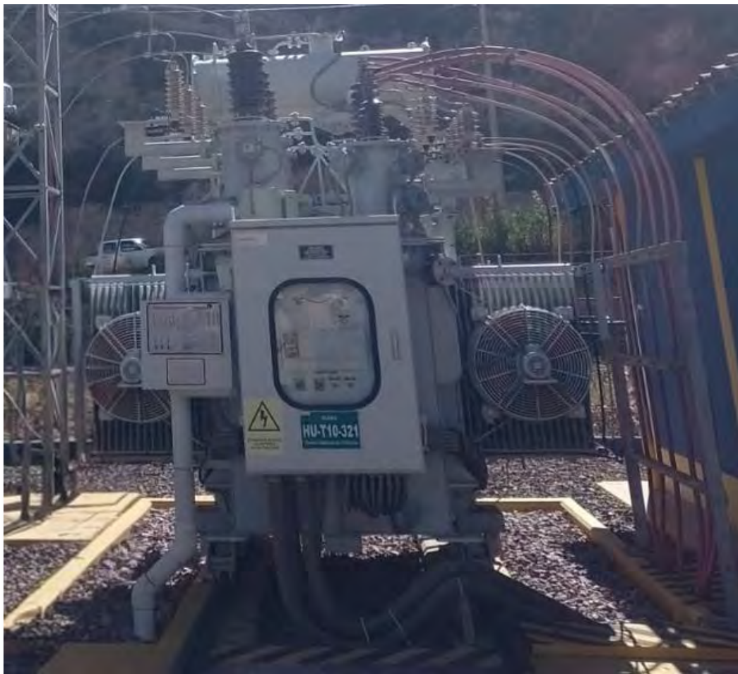
Figura 3.3. Transformador de potencia Trifásico
