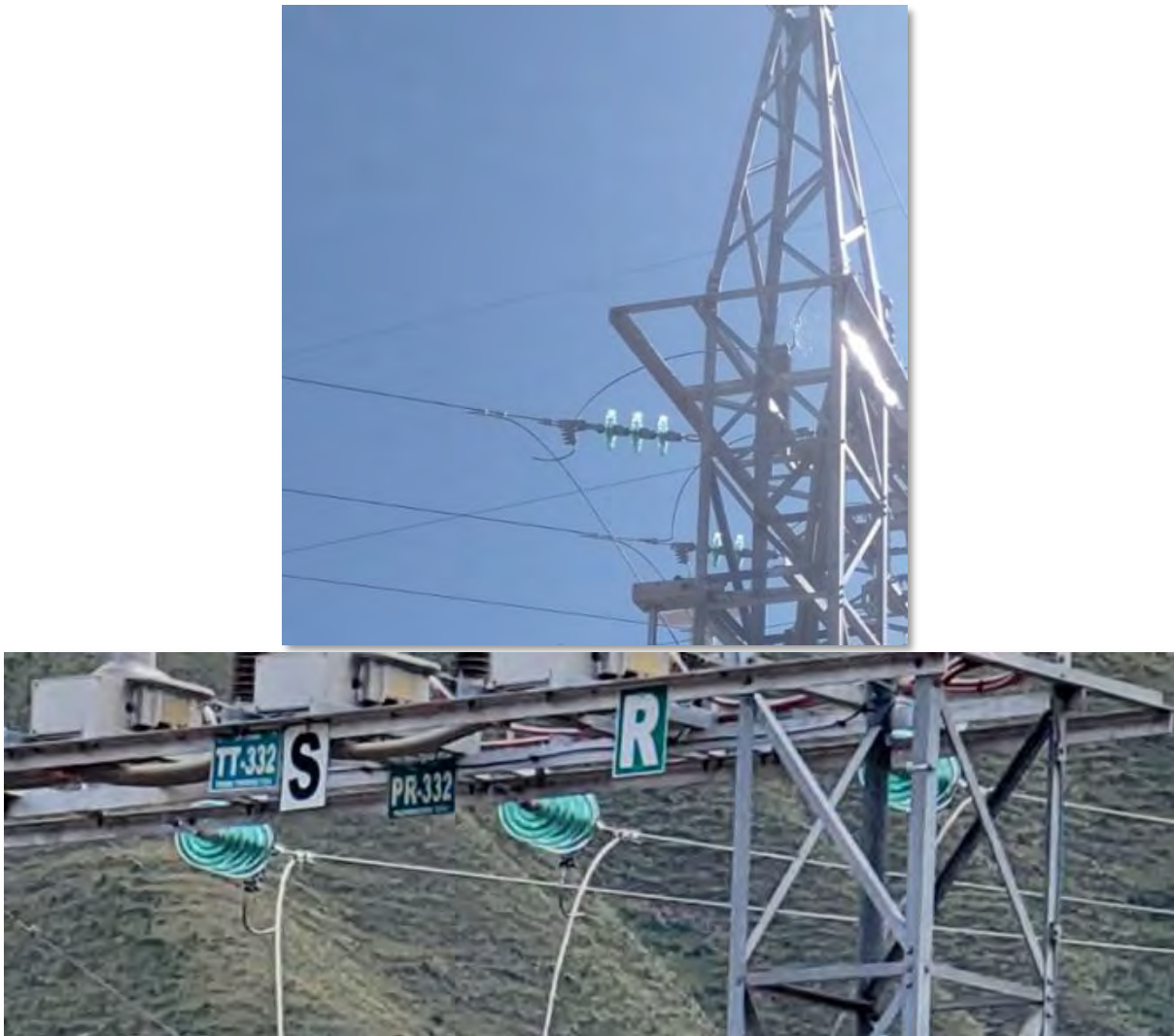
Figura 3.9. Aisladores de vidrio tipo suspensión 52-3.
