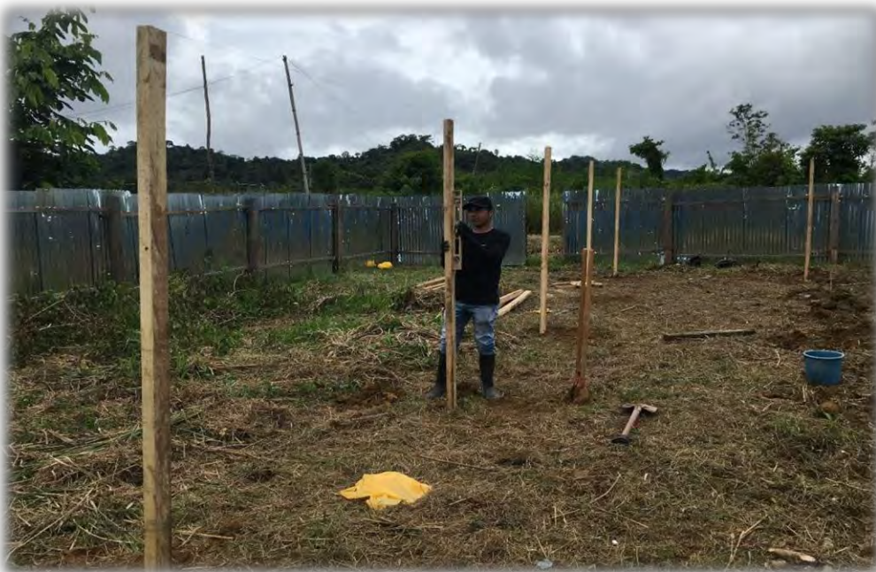
Figura 16. Colocación de soportes de madera para el techado del campo experimental con malla raschel.
