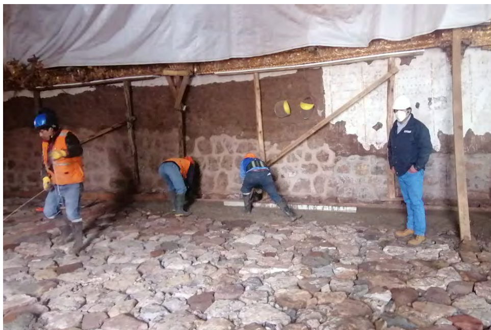
Ilustración 3: Vaciado de falso piso.
