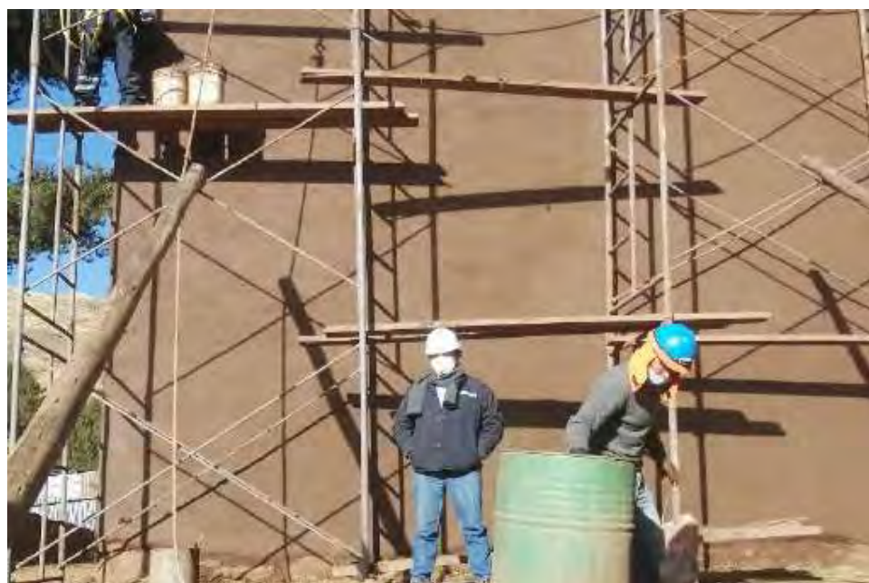
Ilustración 4: Embarre de muros.
