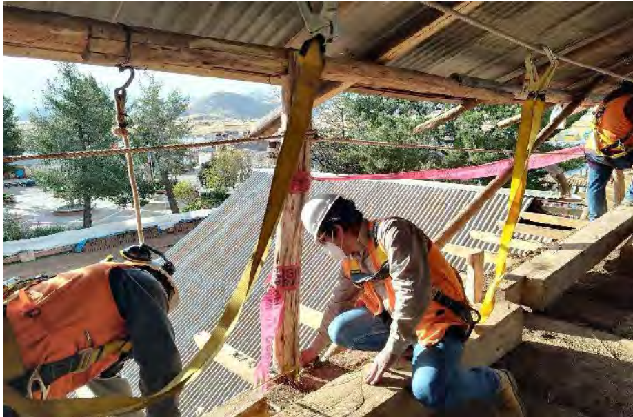
Ilustración 5: Construcción de aleros.
