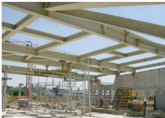
Figura 116 Montaje de la cubierta. Tomado de: Pérez, 2015. Análisis estructural de la evolución del CaixaForum Madrid- Fase 2. Proceso constructivo , p. 8
