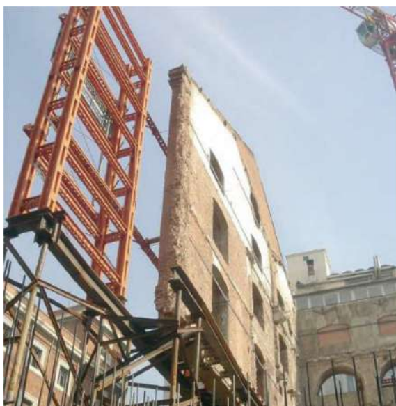
Figura 115 Estabilización de muros originales. Tomado de: Pérez, 2015. Análisis estructural de la evolución del CaixaForum Madrid- Fase 2. Proceso constructivo , p. 4
