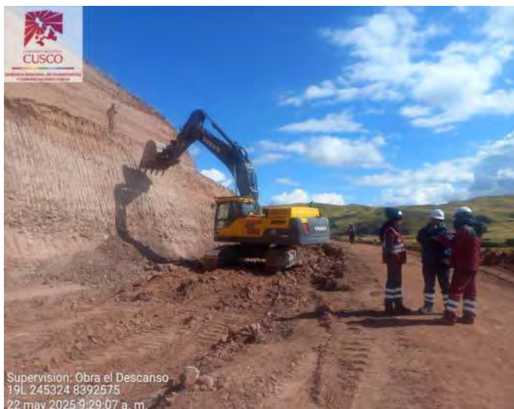
Fotografía 02: Trabajos de excavación para obra de arte - Obra Descanso.
