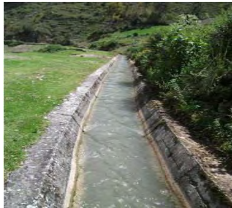
Figura 4.24 Canal revestido con concreto
