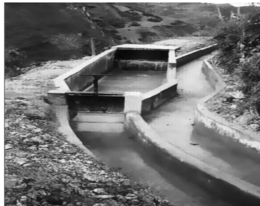
Figura 4.25 Desarenador a la entrada de la cámara
