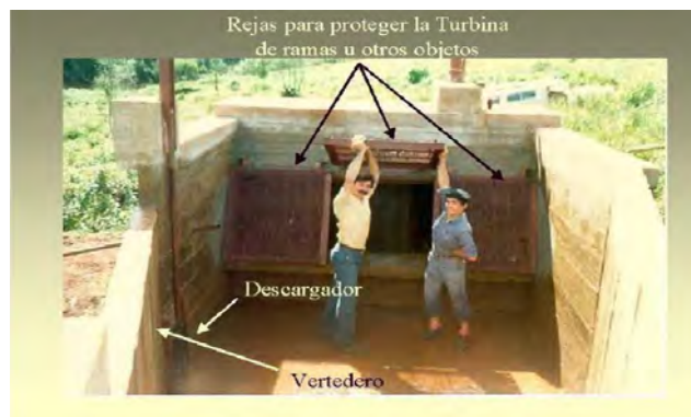
Figura 4.26 Interior de la cámara de carga
