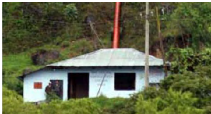
Figura 4.29 Casa de fuerza
