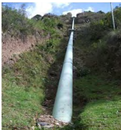
Figura 4.28 Tubería forzada
