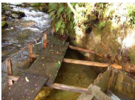
Figura 4.23 Bocatoma
