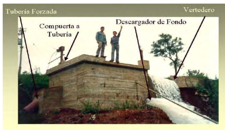
Figura 4.27 Exterior de la cámara de carga
