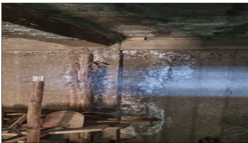
Imagen 16. Eflorescencias en Muro de Contención.
