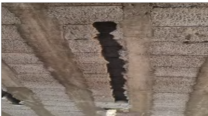
Imagen 19. Losas Aligeradas Deterioradas.
