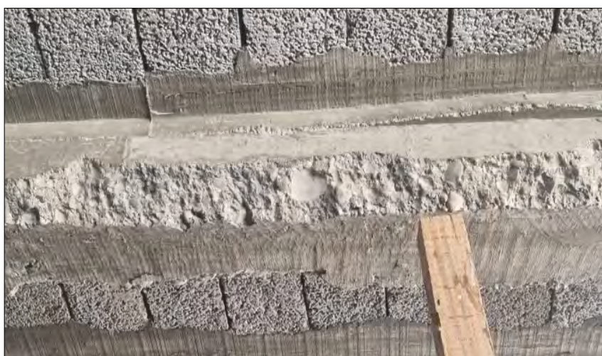
Imagen 18. Vigas Deterioradas.
