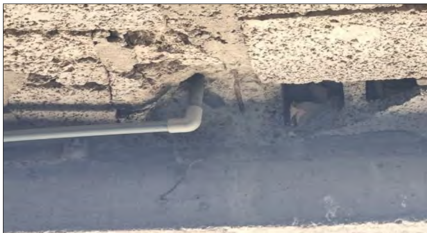
Imagen 20. Pases de Instalaciones Inadecuados.
