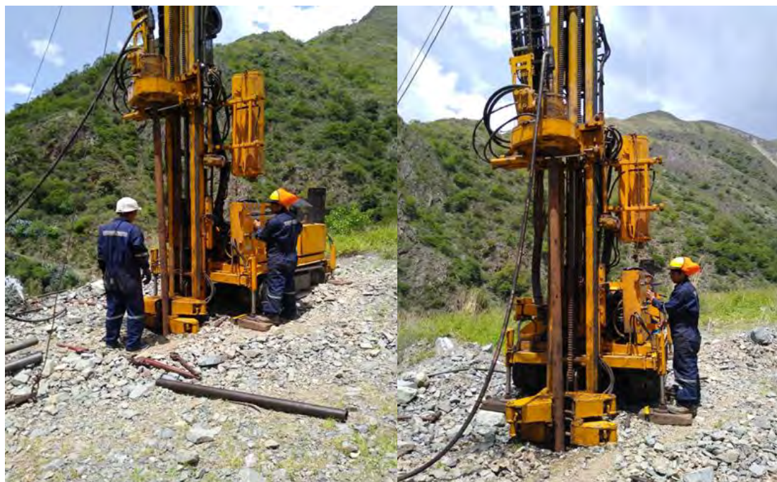
Figura 41. Inicio de la perforación P-03
