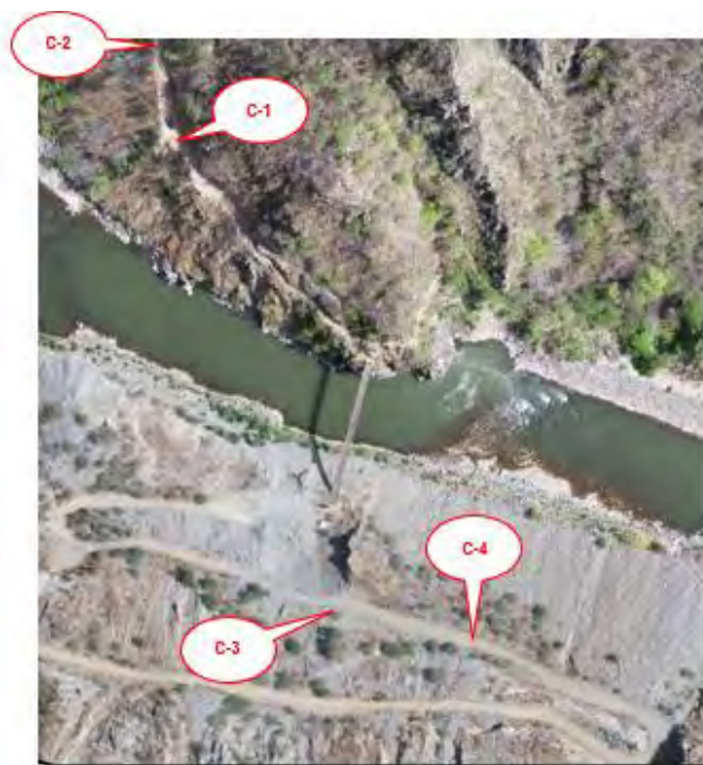
Figura 46: Vista de las calicatas realizadas.
