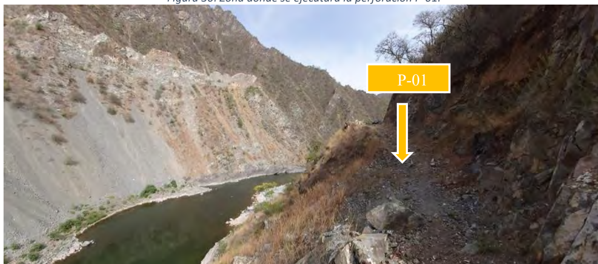
Figura 30: Zona donde se ejecutará la perforación P-01.
