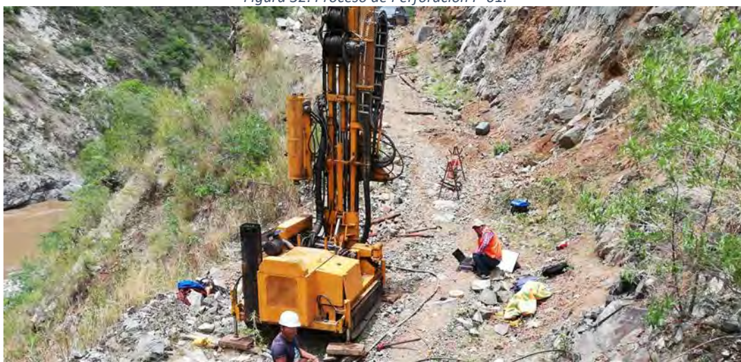
Figura 32: Proceso de Perforación P-01.
