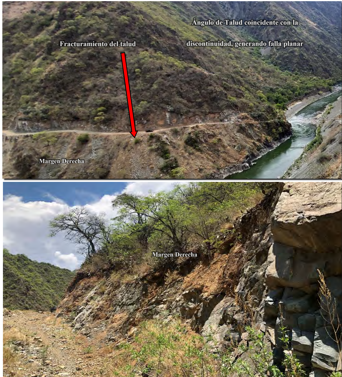
Figura 66: Análisis del talud de la margen derecha donde se emplazará la estructura E1 y accesos.
