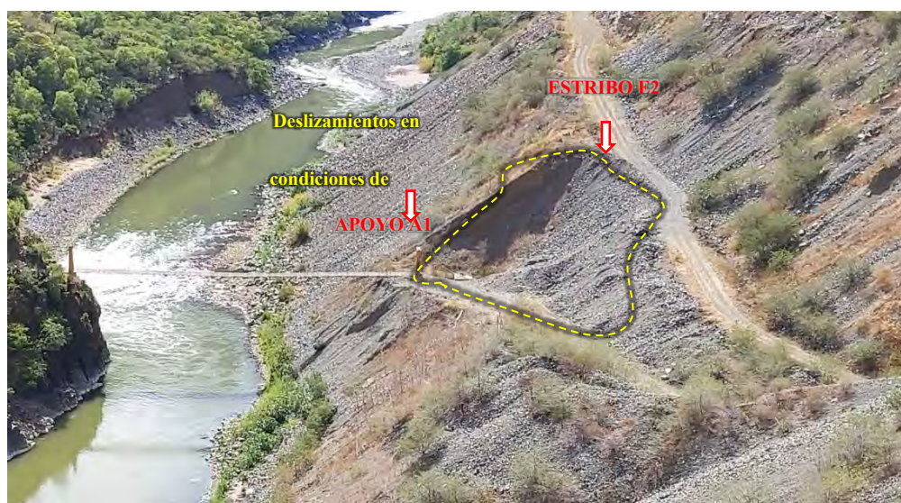
Figura 65: Análisis del talud, condiciones de inestabilidad observadas y propuesta conceptual del sistema de suelo reforzado.
