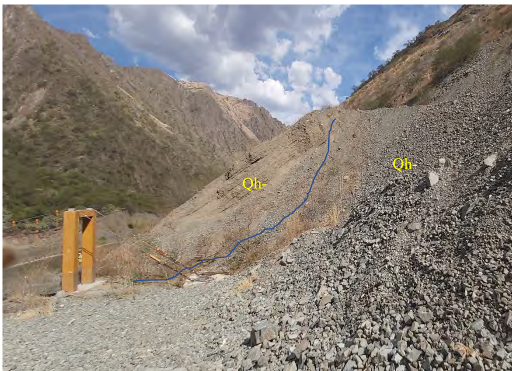
Figura 58: vista de depósitos coluviales cubiertos por el deslizamiento.
