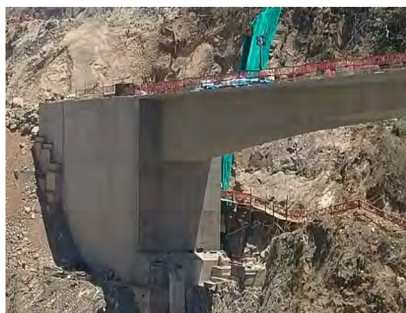
Figura 51: vista de perfil de la cajuela en el estribo derecho E1.
