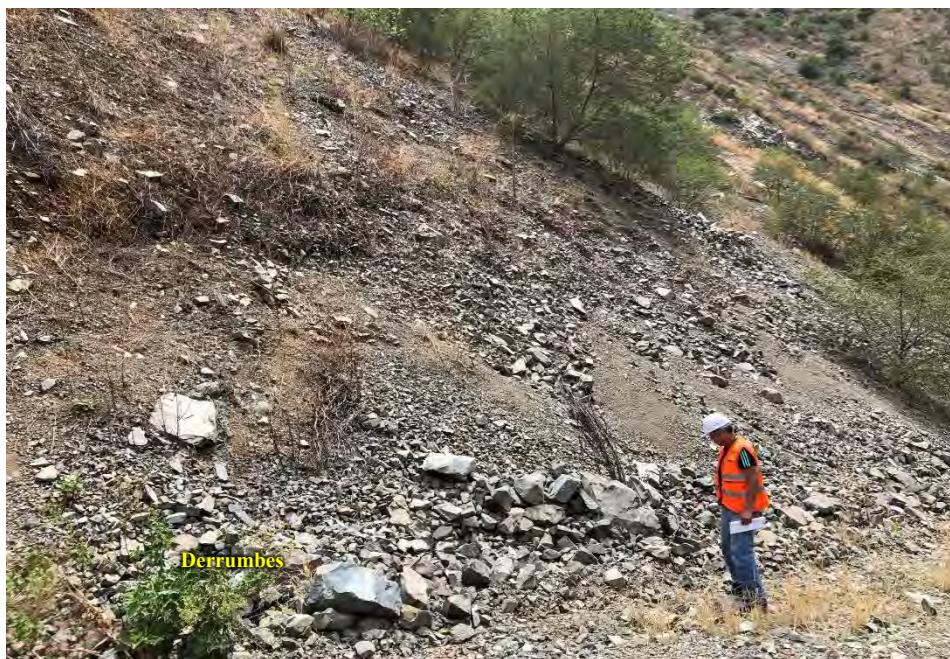
Figura 67: analisis de los derrumbes en la margen izquierda.
