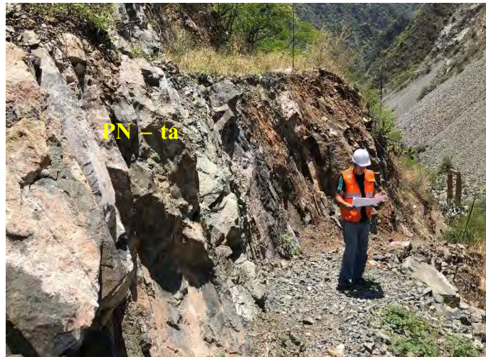
Figura 57: vista del afloramiento del grupo Tacaza en la zona del estribo derecho.
