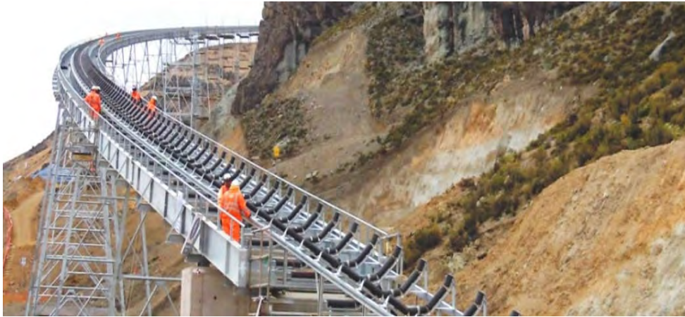
Figura 6. Estructura de una faja transportadora.
