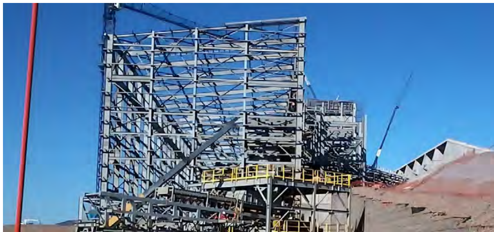
Figura 7. Estructura de acero estructural para planta concentradora.
