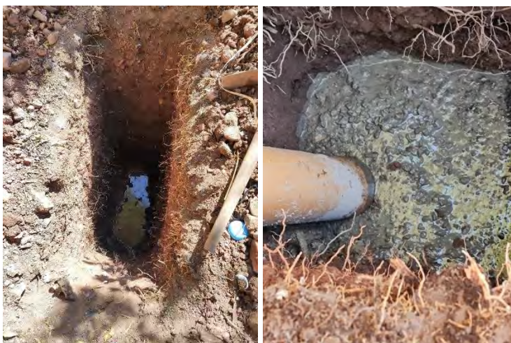
Figura. N°70. Vertido de la mezcla mediante el sistema del tubo Tremie.
