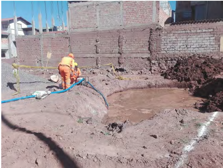
Fotografía N°1. Nivel freático en obra.
