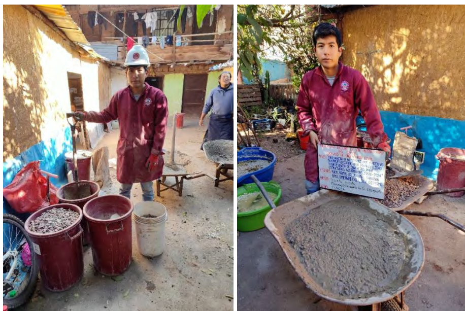
Figura. N°69. Dosificación por volumen de componentes de la mezcla con posterior muestreo de mezcla de concreto.
