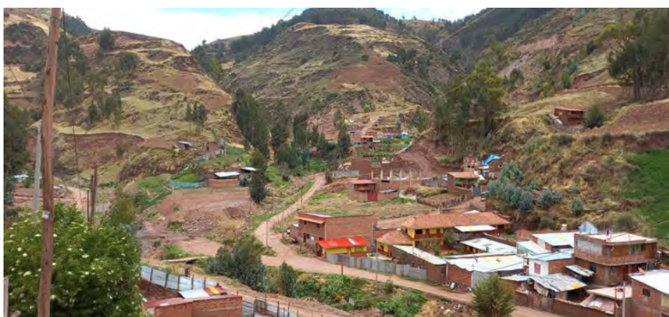
Figura 20: Viviendas asentadas en el cono de deyección de material aluvial.
