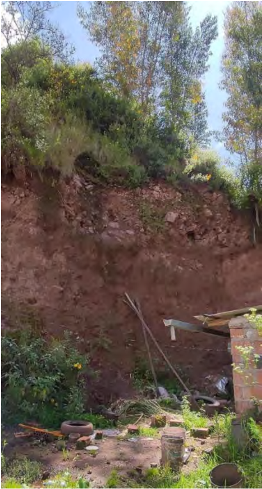
Figura 56: Depósitos coluviales donde se levantó la CE0 N-06.
