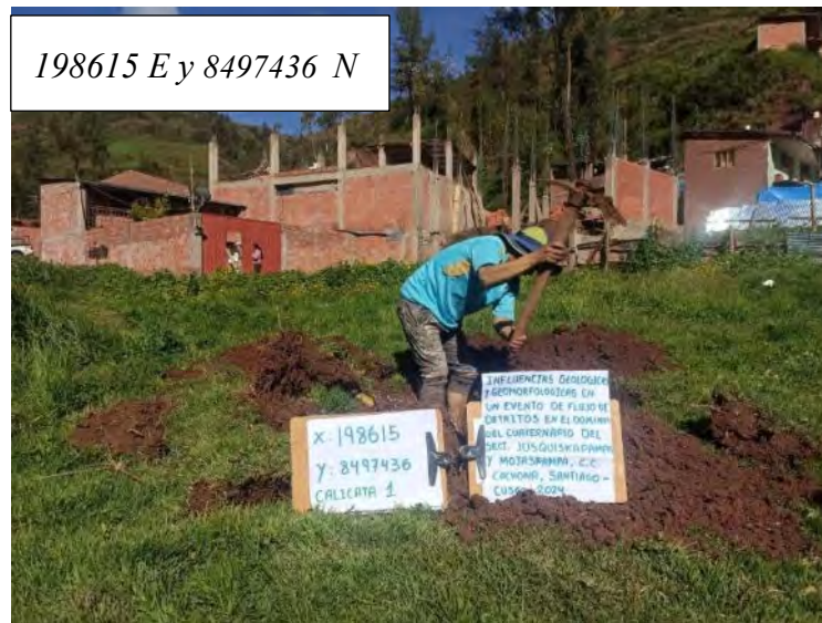
Figura 73: Excavación de calicatas
