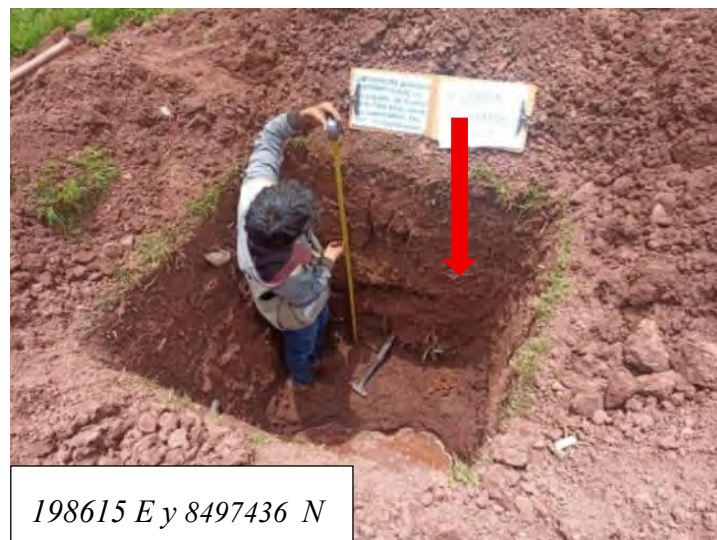
Figura 74: Presencia de nivel freático en la excavación de calicata.
