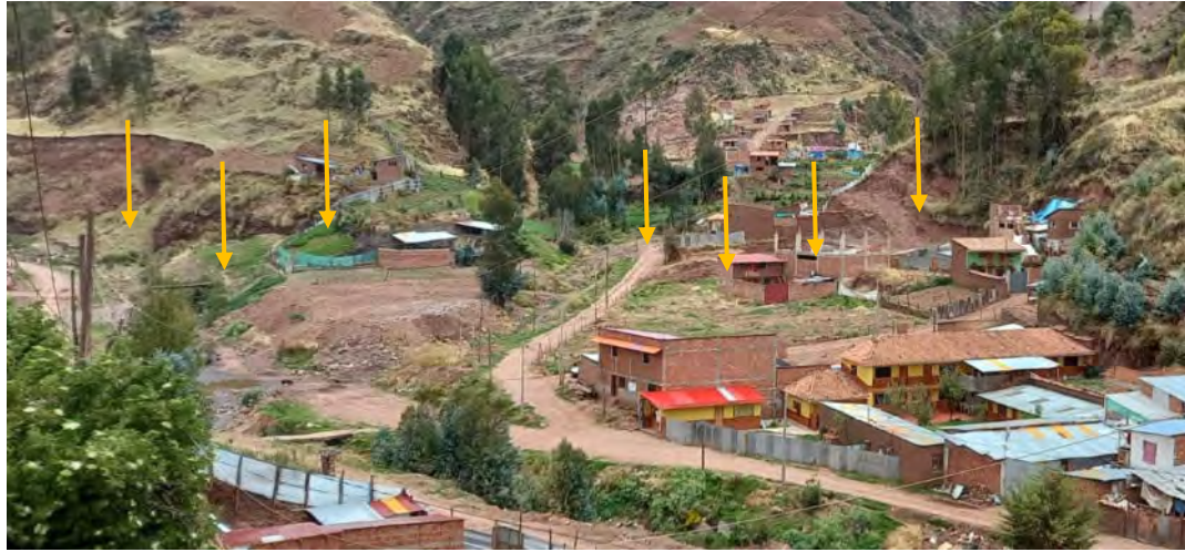
Figura 22: Terrazas aluviales, con viviendas asentadas.
