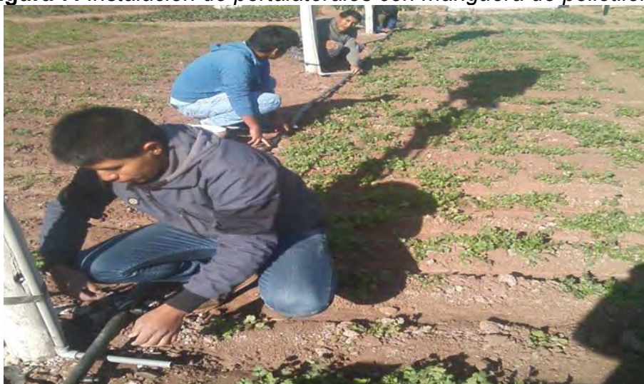
Figura 7: Instalación de portalaterales con manguera de polietileno.
