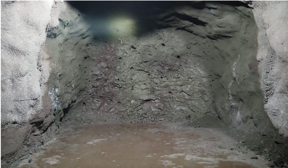
Figura 21. Frente de excavación túnel cordillerano
