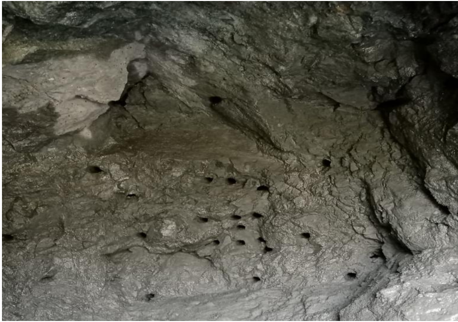
Figura 2. Taladros realizados sobre la estructura rocosa
