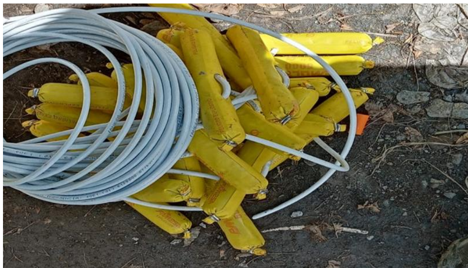
Figura 40. Emulnor de 5000 dispuesto para el proceso de carguío de taladros
