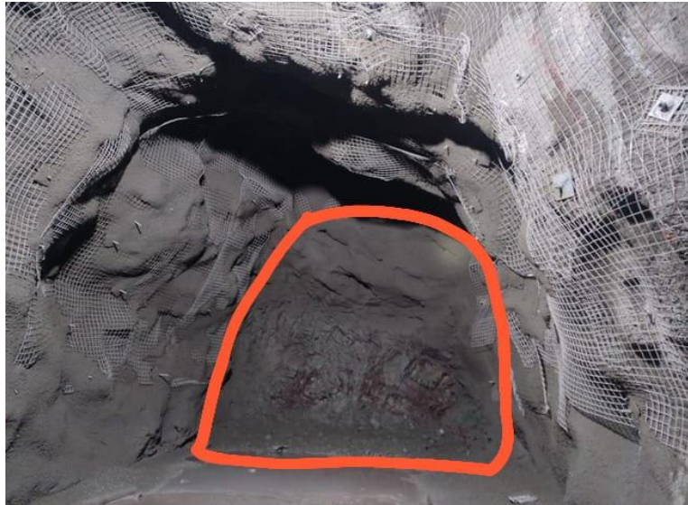
Figura 46. Aplicación de Shotcrete de sacrificio
