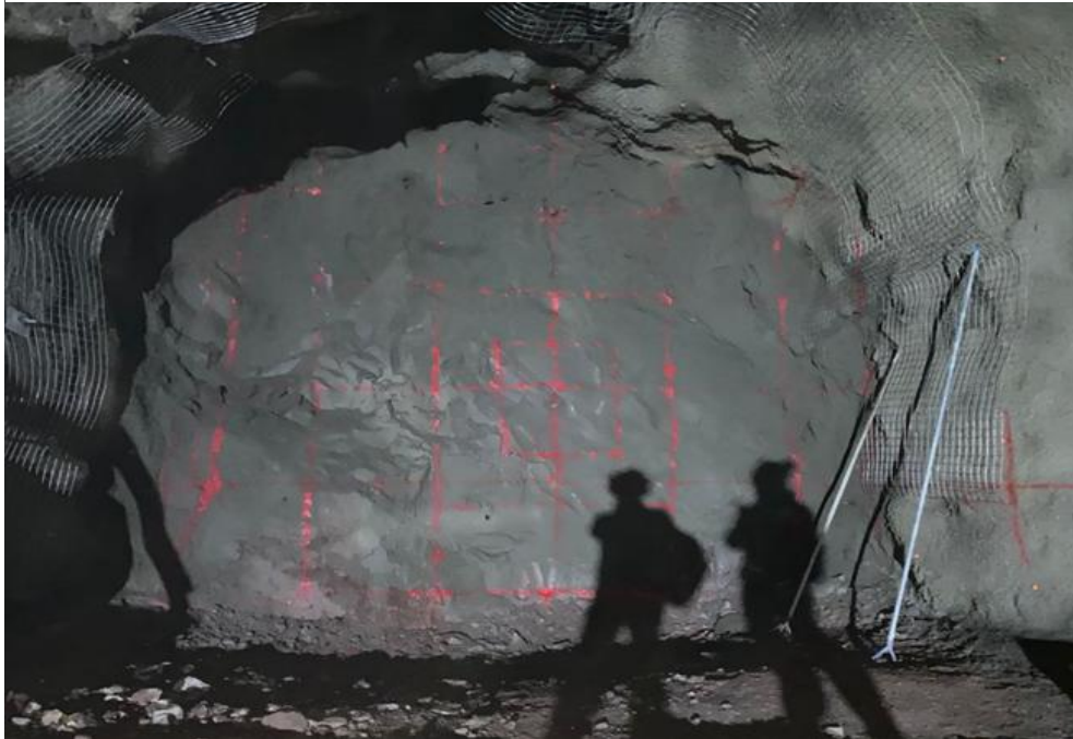
Figura 27. Malla de perforación anterior
