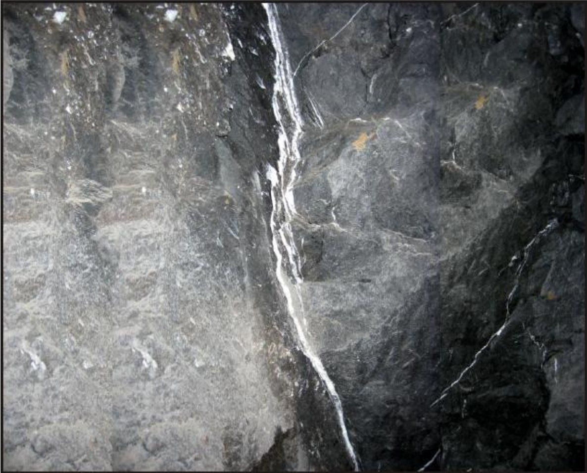
Figura 15. Relleno de las discontinuidades
