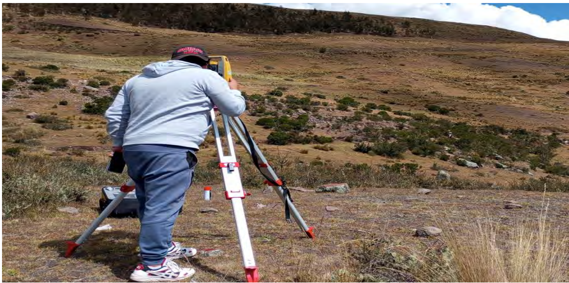
Ilustración 23. Levantamiento de puntos topográficos.
