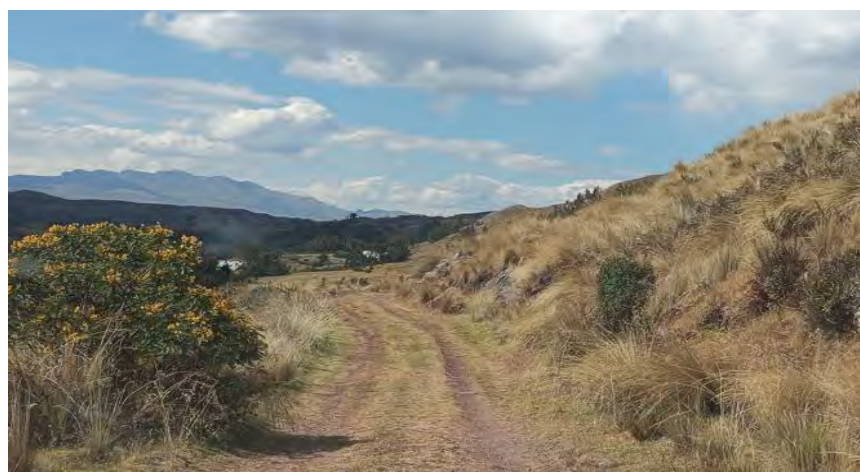
Ilustración 14. Camino rural sin peralte y con ancho de calzada menor a 3.00 mts.
