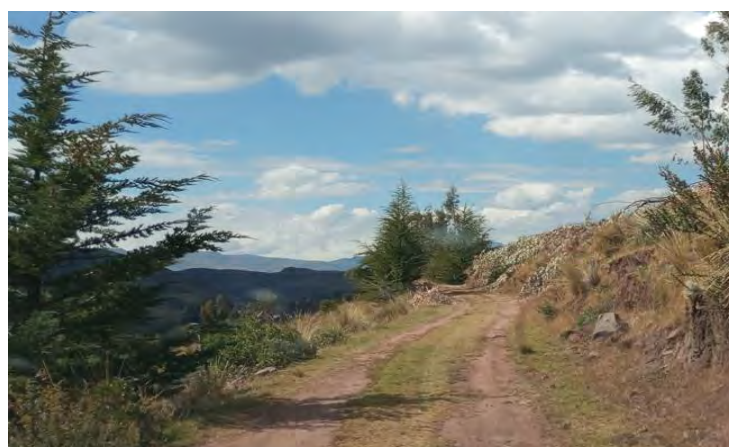
Ilustración 15. Camino rural en pésimo estado de conservación.
