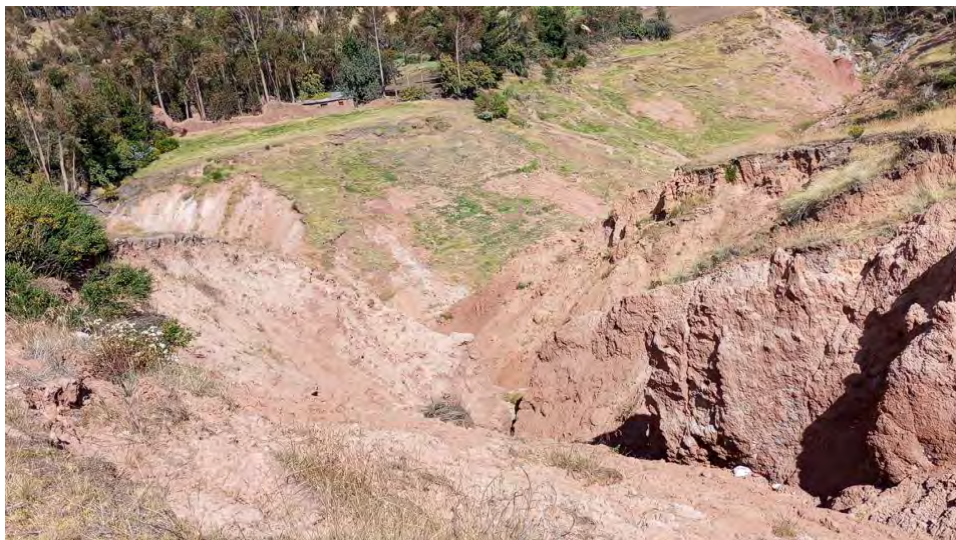
Ilustración 25, Evaluación y observación la falla geológica existente. Comunidad de Occopata.
