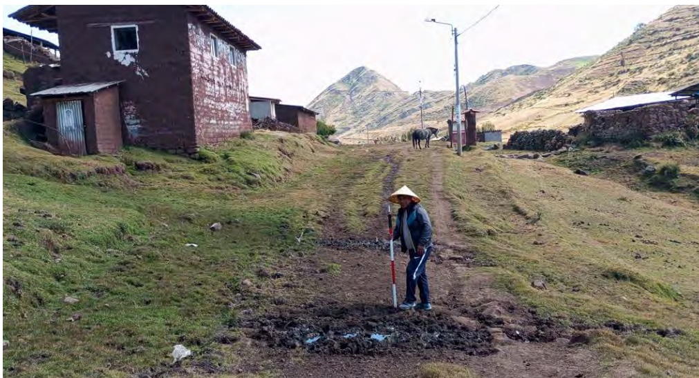
Ilustración 9. Superficie de rodadura en mal estado de conservación. Comunidad de Huasampata.
