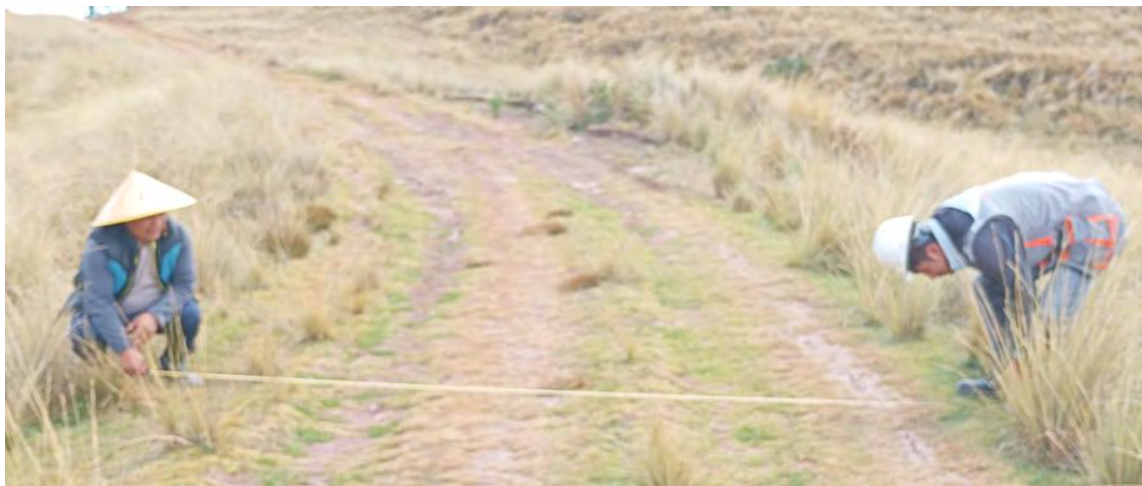
Ilustración 29. Levantamiento preliminar de ancho de calzada - tramo 2 - comunidad de Huasampata.
