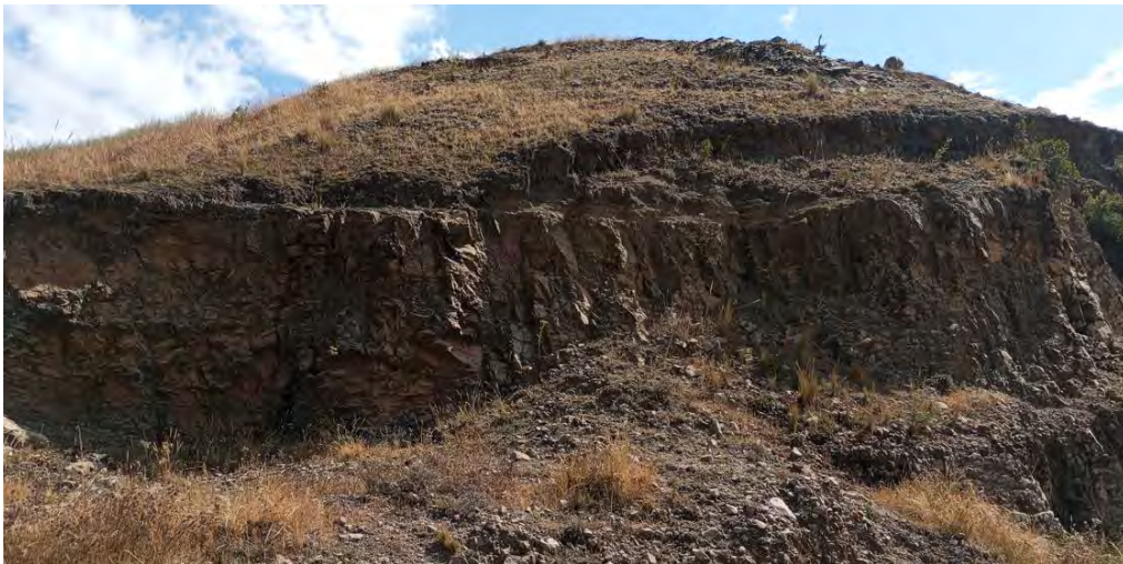
Ilustración 18. Taludes en el camino rural existente.
