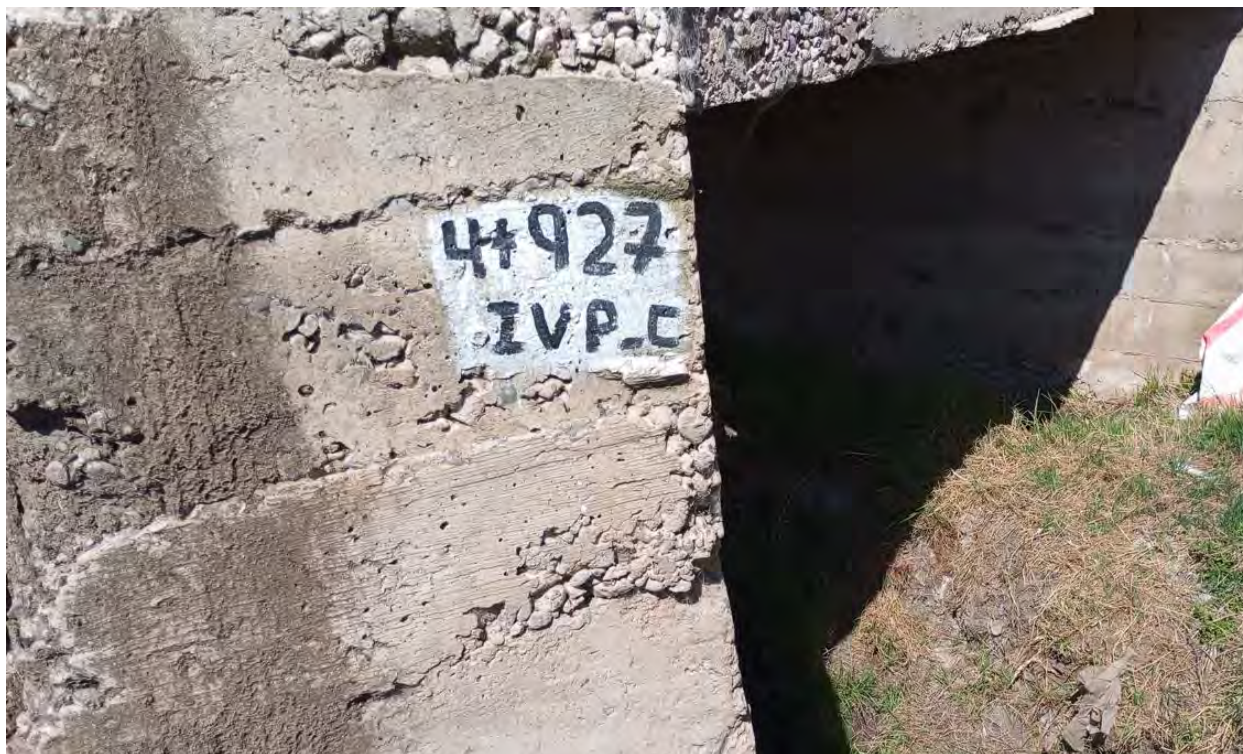
Ilustración 4. Marca de progresiva Pontón existente comunidad de Huasampata
