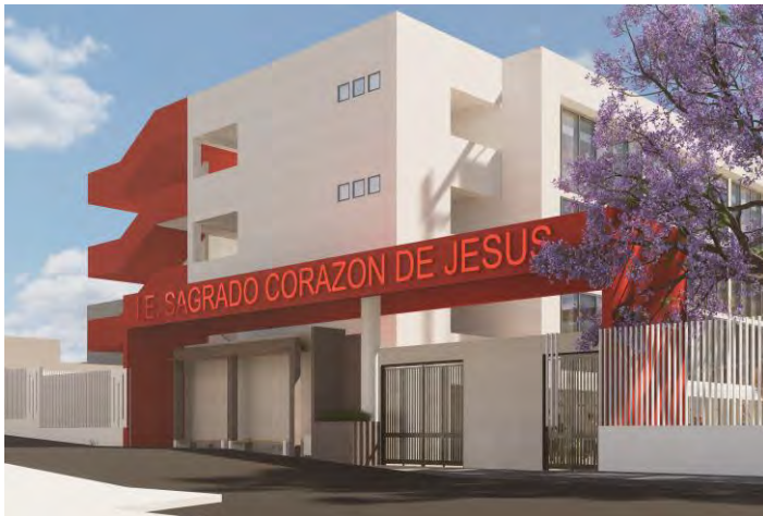
Figura 141. Acceso secundario Fuente: Elaboración propia
