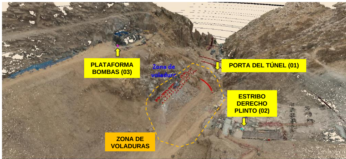
Figura 27. Ubicación de puntos de monitoreo de vibraciones
