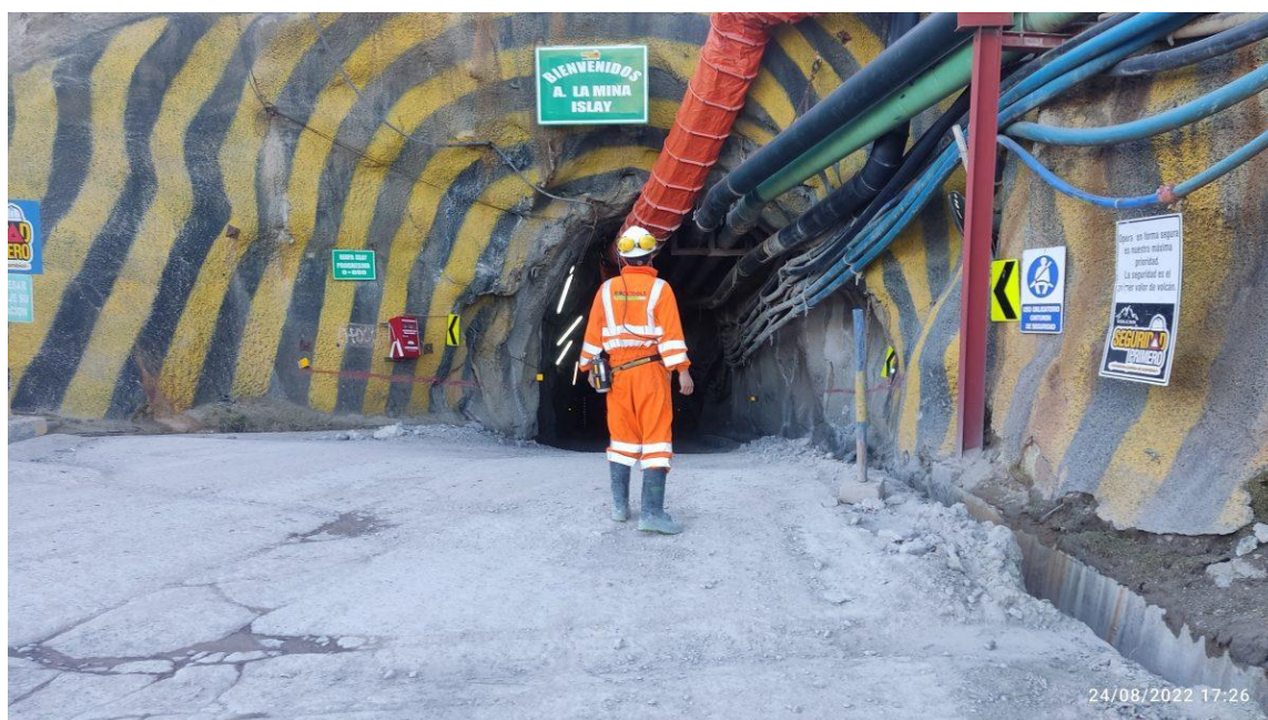
Figura 5. Acceso a la galería principal
