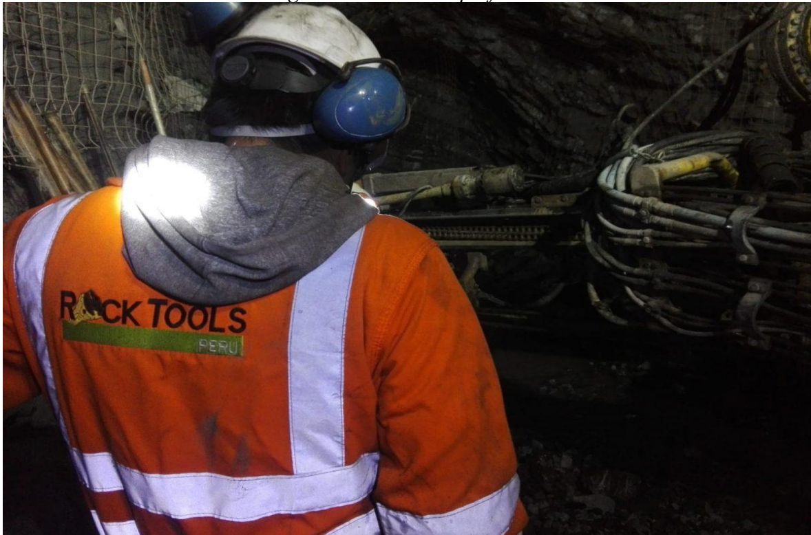
Figura 7. Labores de perforación
