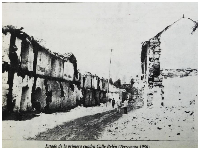
Estado de la primera cuadra Calle Belén (Terremoto 1950)
