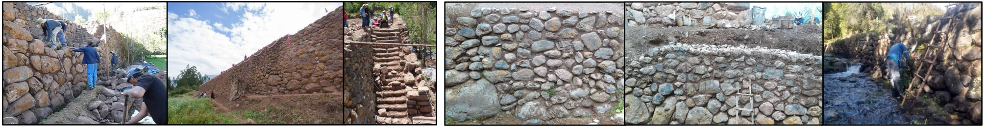
Intervenciones restaurativas de andenes y escalinatas principales (Portada del Sol) en Yucay por la DDC-Cusco
