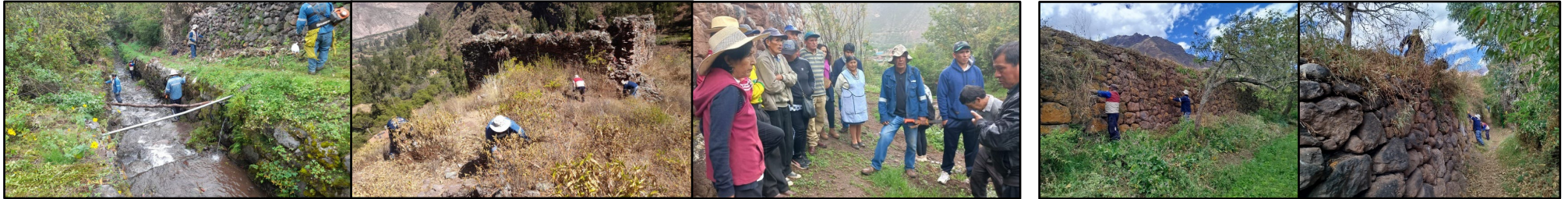
Limpieza de vegetación en canales (Tenería y Hatun Ñan), caminos prehispánicos (Tenería y Hatun Ñan) y otras estructuras, así como sensibilizaciones con los usuarios de los andenes de Yucay (DDC-Cusco)
