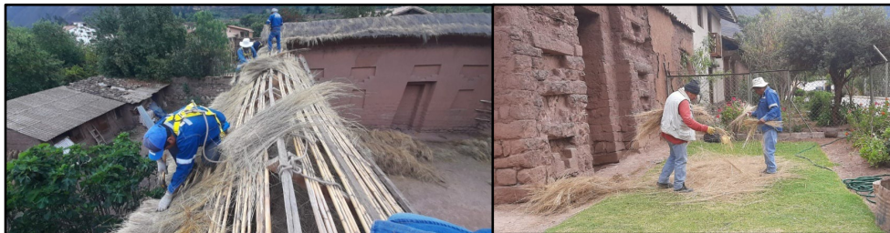
Techado y repaje del palacio Sayri Túpac por la DDC-Cusco
