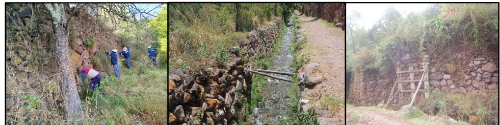
Limpieza, apuntalamientos y entibados en canales, caminos y andenes principales de los andenes de Yucay por la DDC-Cusco
