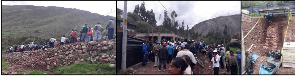
Inspección y paralización a un inmueble por la DDC-Cusco y la MDY entre los andenes de Yucay y Huachaq
