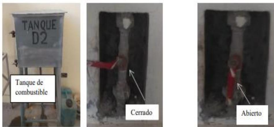
*Nota: Para el abastecimiento de agua al tanque de ablandamiento, condensado y generador debemos aperturar la válvula principal de agua y que el tanque de combustible este abastecido por lo menos  $\frac{1}{2}$  tanque de combustible.*
