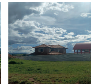
(6)Construcción en Adobe en Piuraypampa
