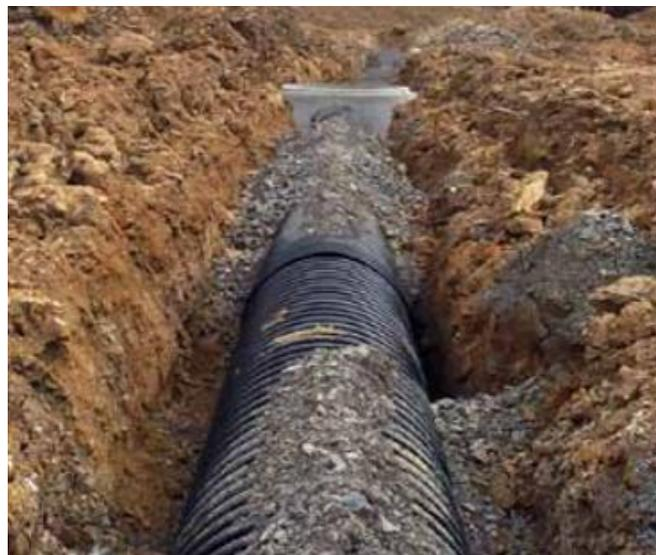
Imagen 05.- Instalación de tubería hdp en la progresiva Km 0+000 a1+000 (Fuente: Sidelsa).
