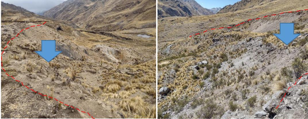
Fotografía 20, 21.- Zona deslizamiento, en la línea de conducción
