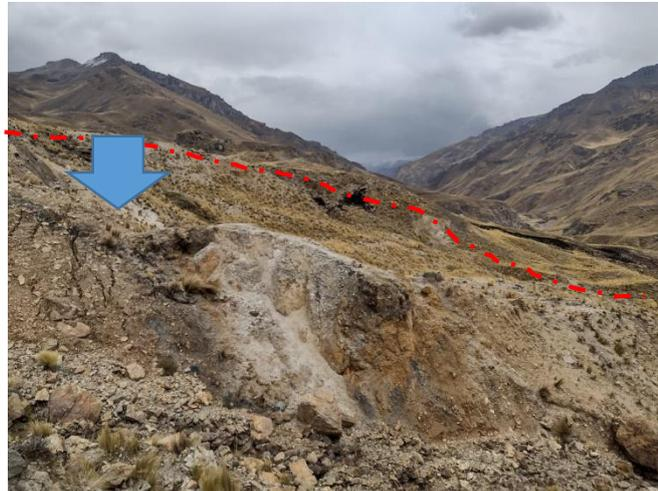
Fotografía 38.- Deslizamiento superficial en la progresiva 0000-0+700km
