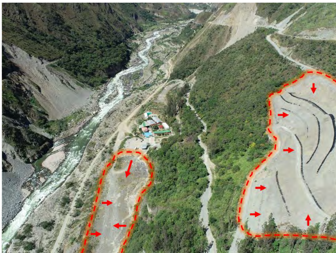
Foto 12 _Desmonte del material externo, depositados durante la ejecución del Proyecto Mejoramiento de la Carretera Santa María - Santa Teresa - Puente Hidroeléctrica Machu Picchu.
