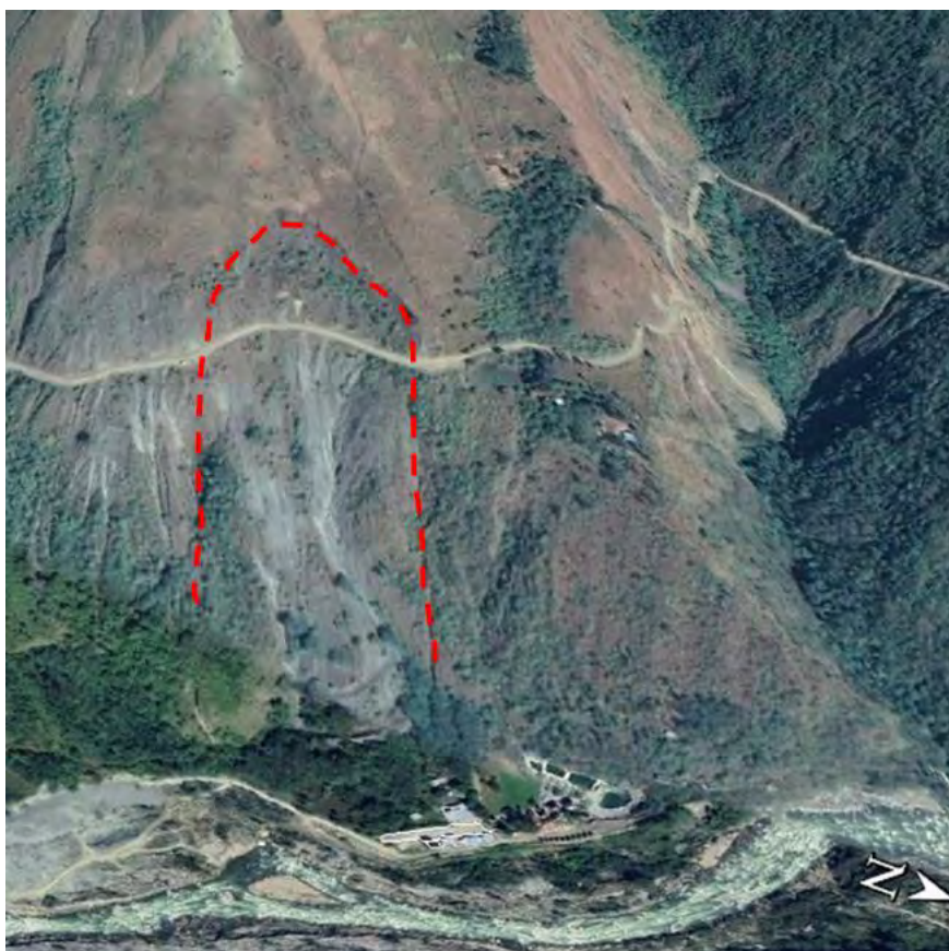
Foto 19_perímetro del deslizamiento
