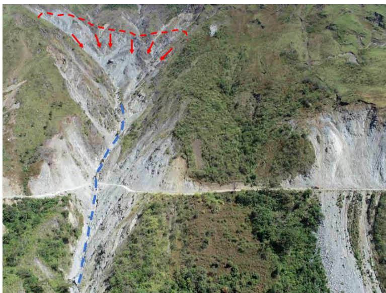
Foto 3_Circo de erosión
