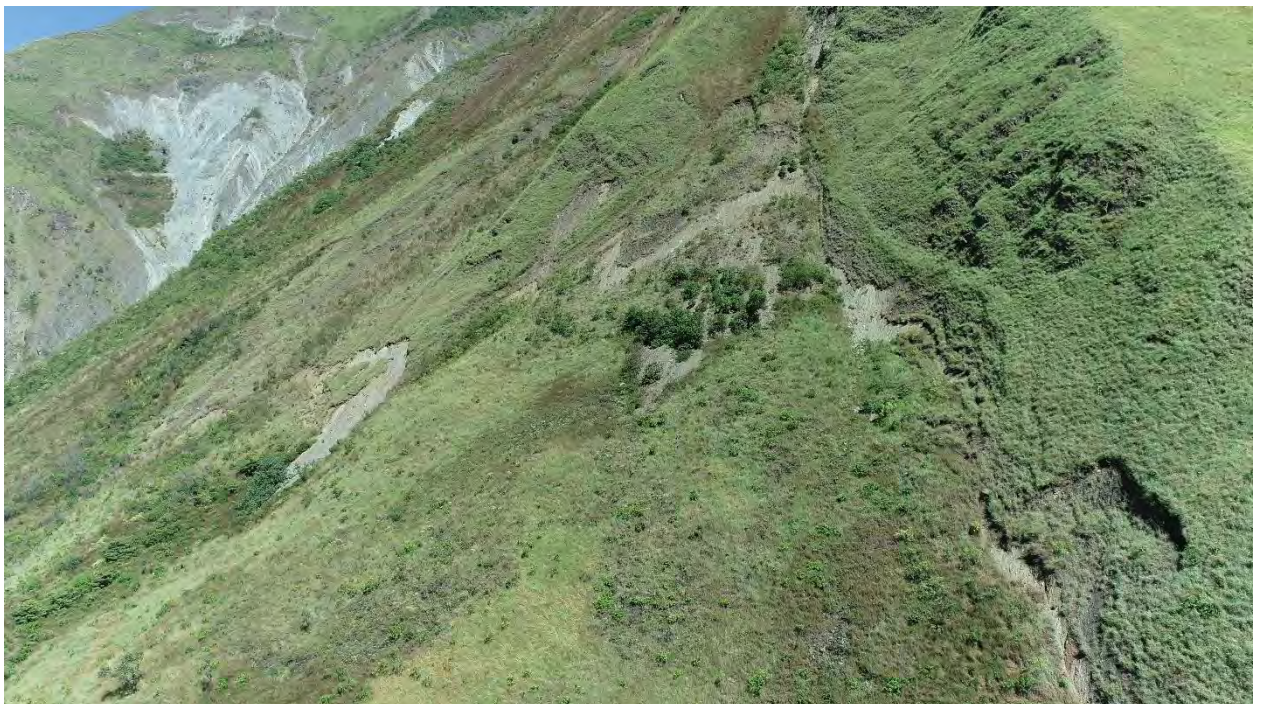
Foto 16 _Escarpa de falla
