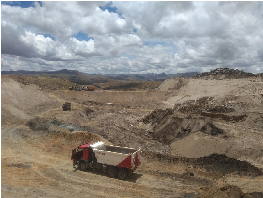
Fotografía 11: Extracción de material del vaso de la presa
