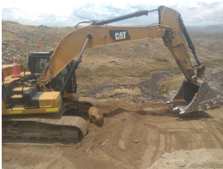
Fotografía 2: Retiro de Topsoil
