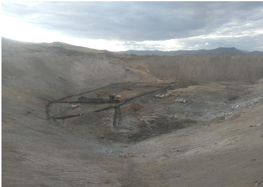
Fotografía 18: Construcción del drenaje de la presa
