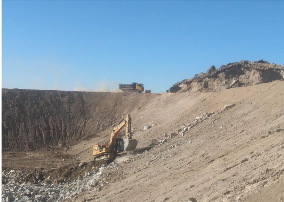
Fotografía 15: Conformación de los taludes de la presa
