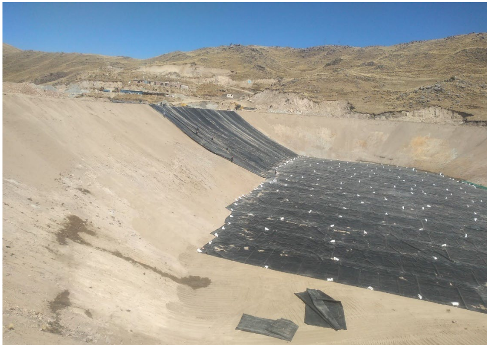
Fotografía 22: Revestido de talud de la presa con Geomembrana
