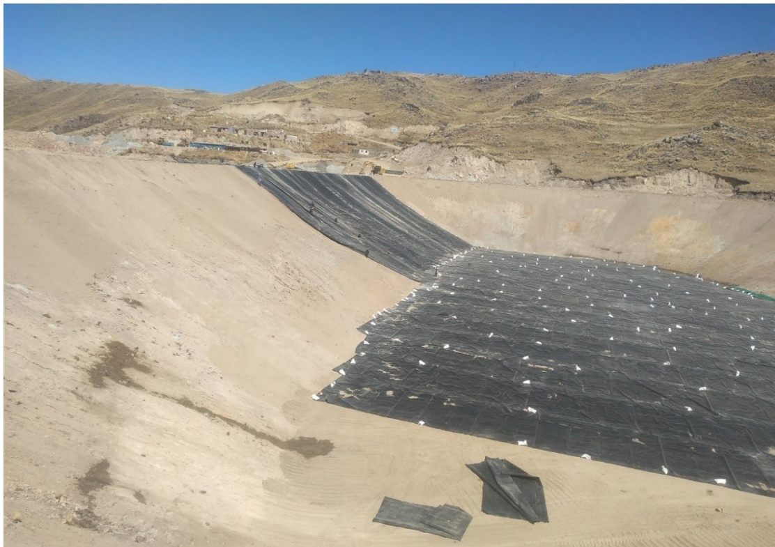
Fotografía 8: Tendido de geomembrana en los taludes.
