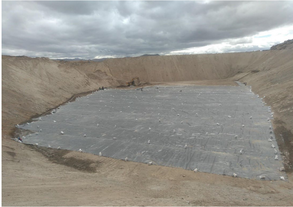
Fotografía 21: Revestido de la base de la presa con Geomembrana
