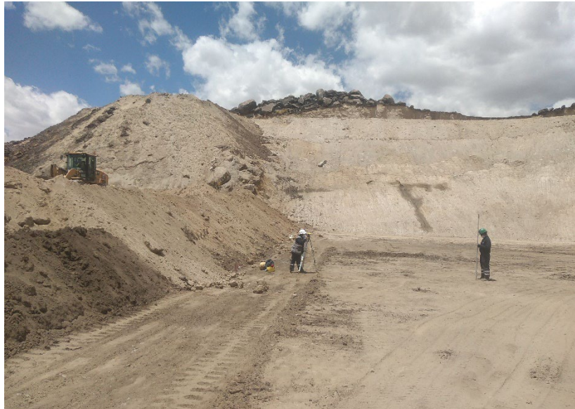
Fotografía 4: Construcción de Dique
