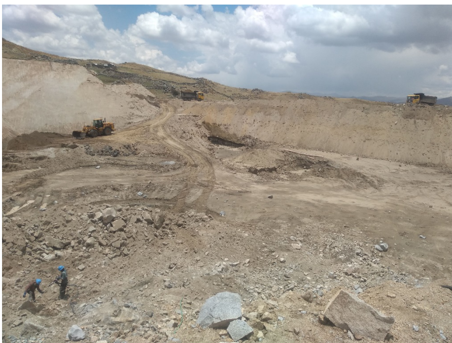
Fotografía 12: Extracción de material del vaso de la presa
