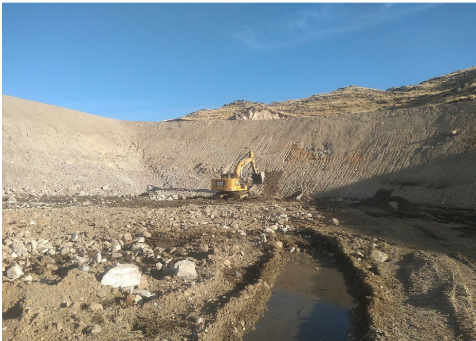
Fotografía 16: Conformación de los taludes de la presa
