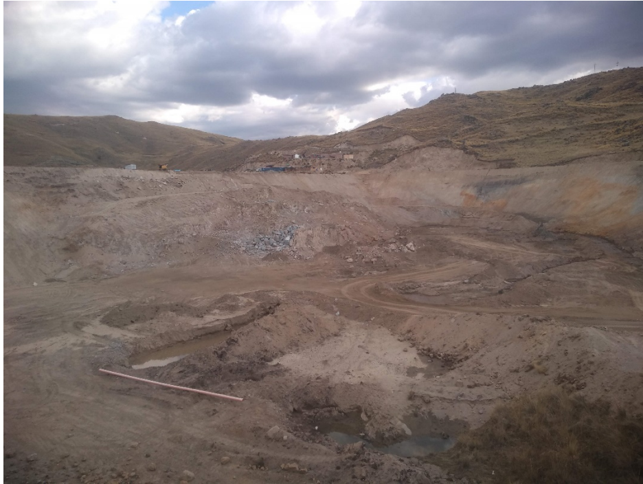
Fotografía 17: Construcción del drenaje de la presa
