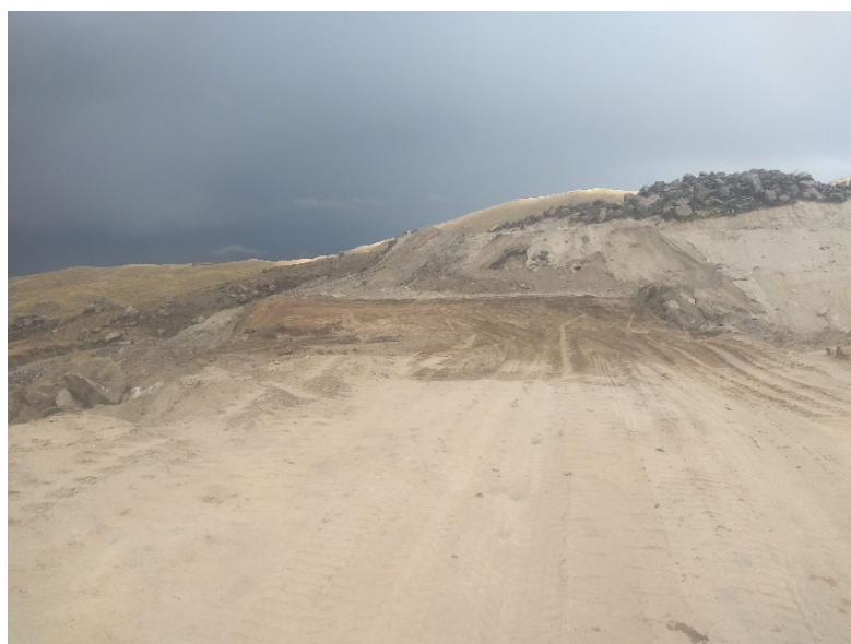
Fotografía 3: Retiro de Topsoil
