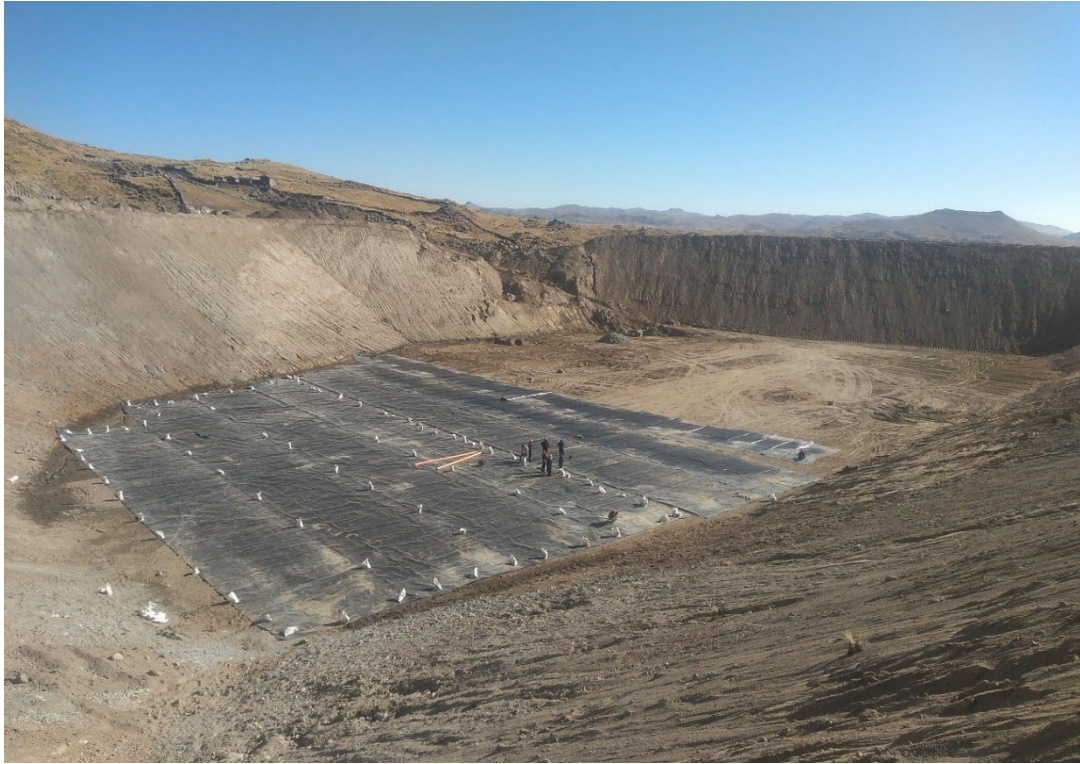
Fotografía 7: Proceso de tendido de la geomembrana
