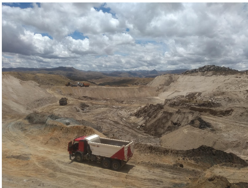
Fotografía 5: Cierre de Dique
