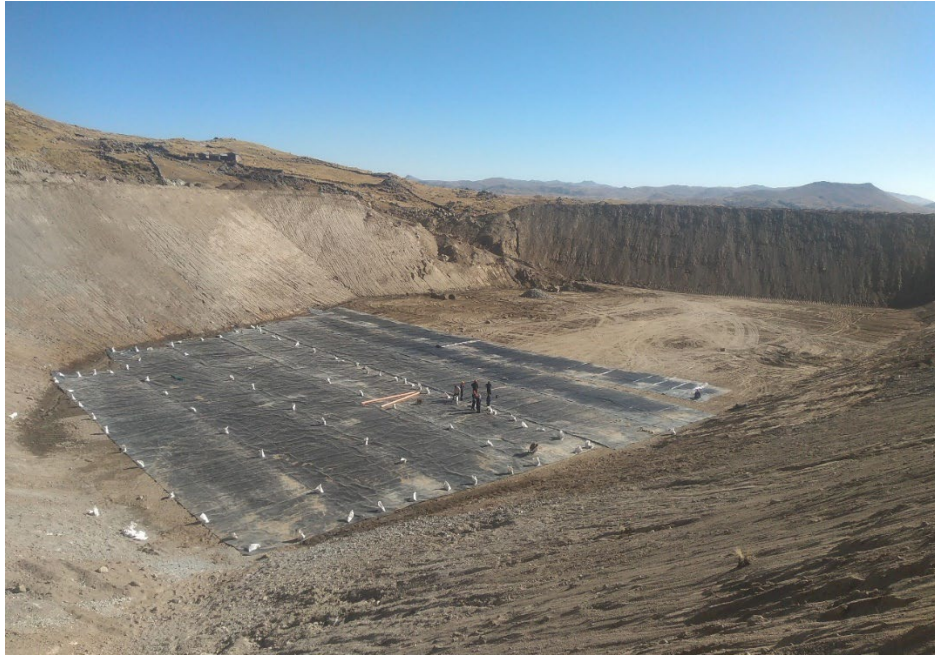
Fotografía 19: Revestido de la base de la presa con Geomembrana
