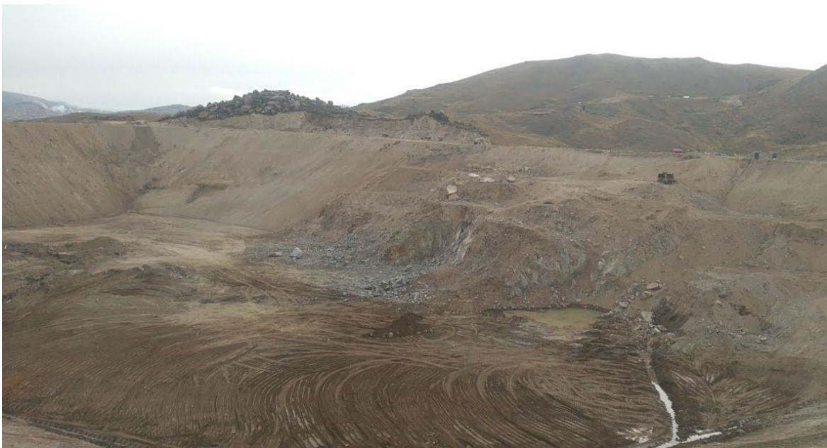
Fotografía 14: Extracción de material del fondo del vaso de la presa
