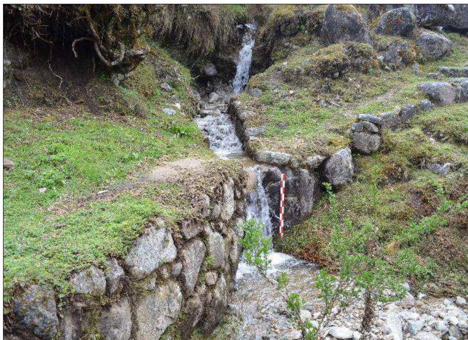
Figura 142: Fotografía del camino ubicado en el sector de San Antonio de Chupana, véase detalle de los elementos líticos desbastados de volumen mediano a pequeño.
