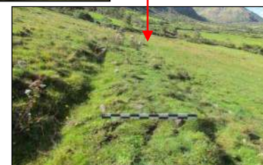
Vista del camino inca colapsado en el sector de Pumachaca, véase detalle de los drenes laterales y el camino del tipo calzada empedrada colapsado en un área pantanosa.
