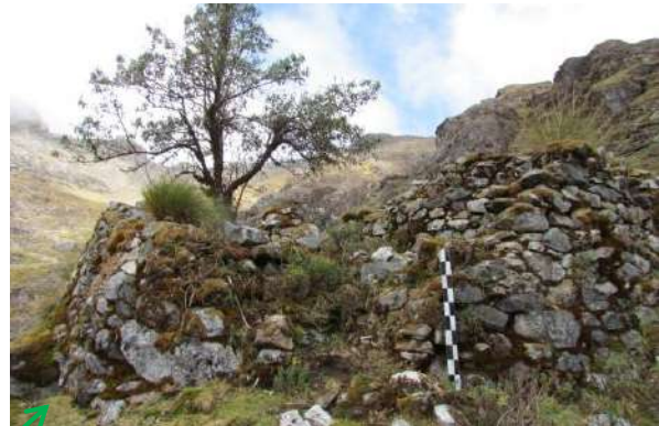
Fotografía recinto N° 2: Véase el colapso en la parte posterior y el factor ambiental que lo deteriora.
