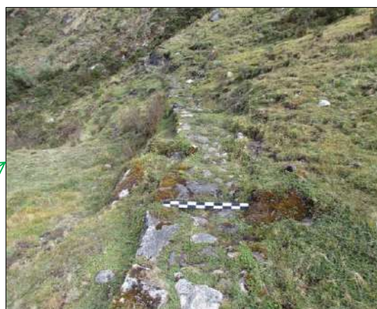
2. Vista del camino afectado por la filtración de aguas subterráneas.
