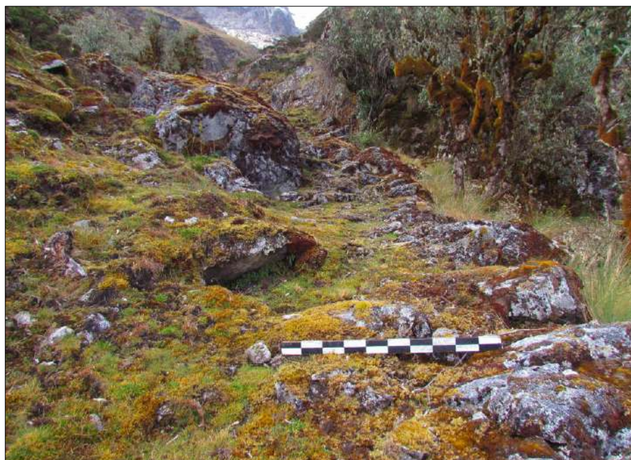
Figura 143: Fotografía del camino ubicado en el sector de Azulq'aqa, véase detalle de los bloques líticos de volumen grande, producto del desprendimiento del cerro.
