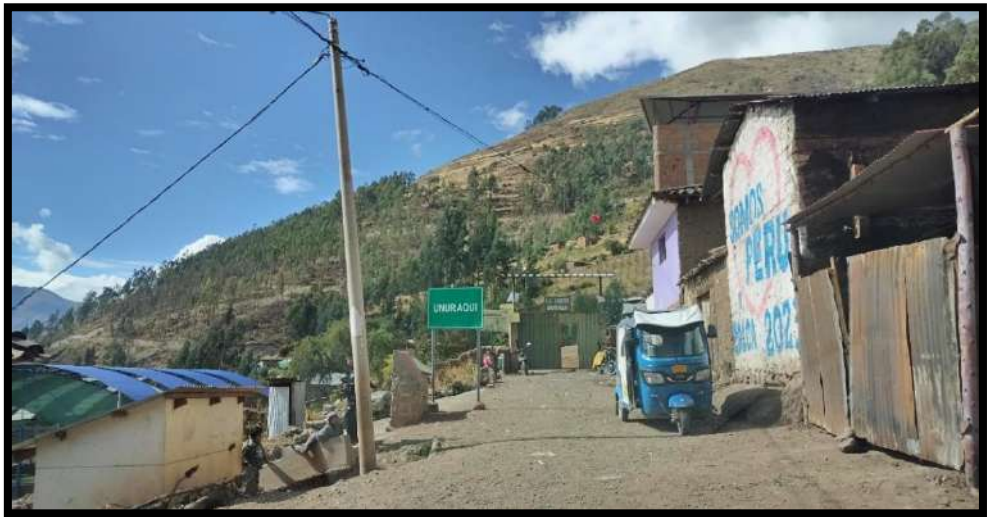
Inicio del eje de tramo progresiva 0+000
