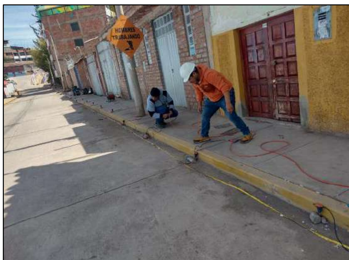
Figura 18 : Ensayo 62-MASW realizado por los testistas en el frontis del emplazamiento del proyecto.
