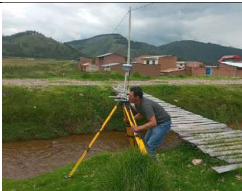
Fotografía 3. Nivelación de GNSS.
