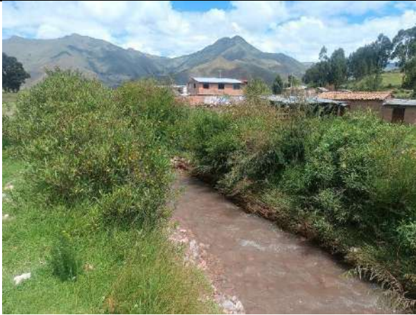
Fotografía 9. Presencia de vegetación en el canal del río Ccancahua.
