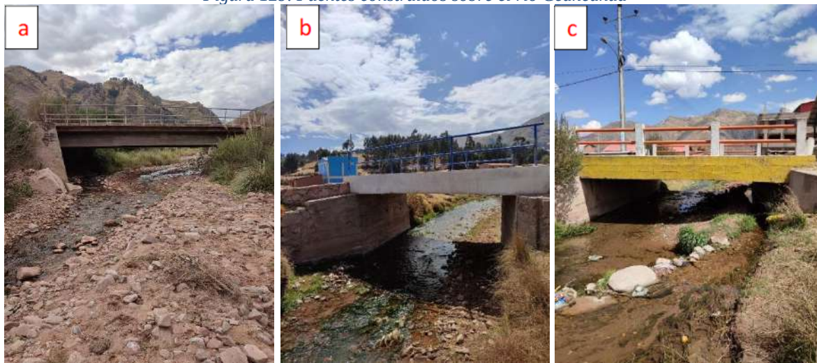
Figura 129. Puentes construidos sobre el río Ccancahua
