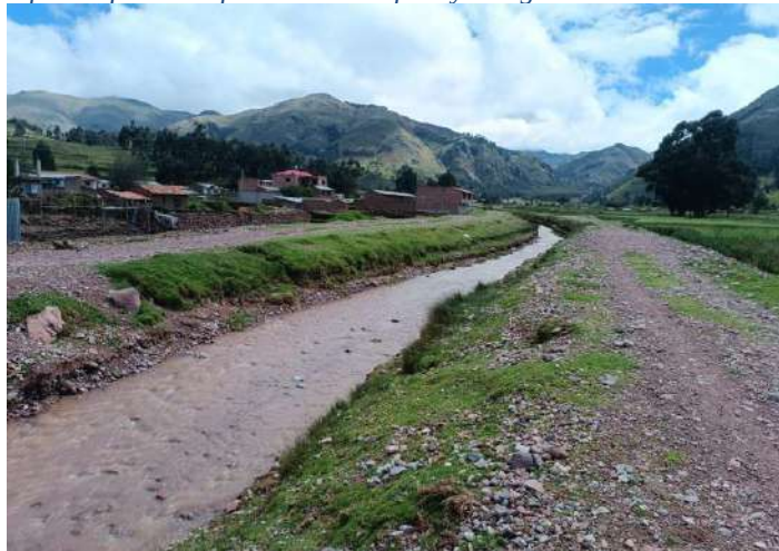
Figura 32. Depósito fluvial depositado en el piso y márgenes del canal del río Ccancahua
