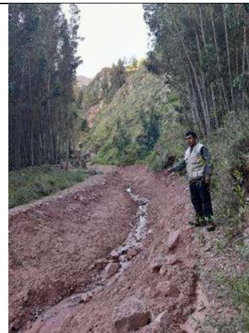
Fotografía 12. Canal del material proluvial reciente de la quebrada Suchu Q'uchu.
